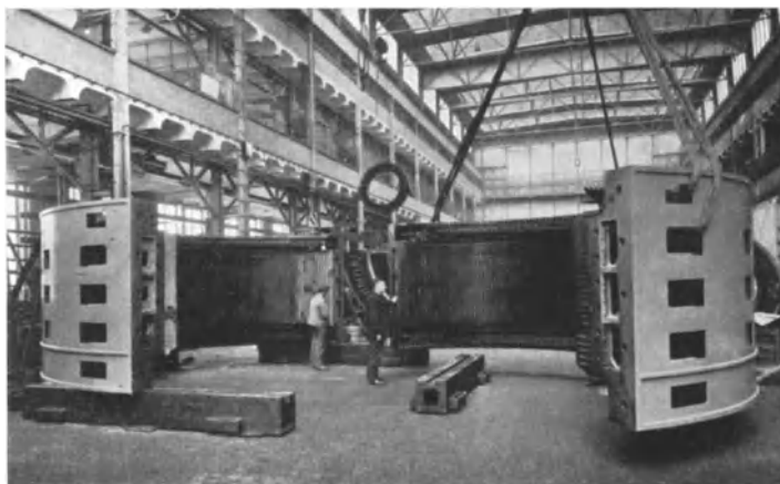
Abb. 34 b. Die beiden Ständerhälften des Drehstromgenerators kurz vor dem Zusammensetzen zwecks Aufbau auf dem Prüffeld.
