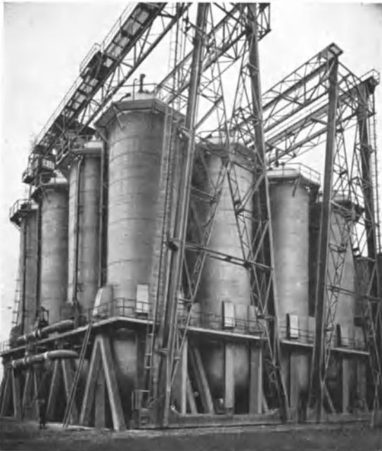
Abb. 60. Ruths-Speicher-Anlage. (Aus Siemens-Jahrbuch 1930.)
