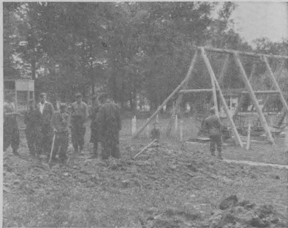
Bild 91: Volkspark. Ukrainische Arbeiter beim Ausheben der Massengräber
