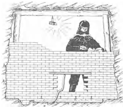
Fig. 579. Herstellung eines Mauerdammes mit Mannloch unter Verwendung eines Druckschlauch-Atmungsgerätes.
