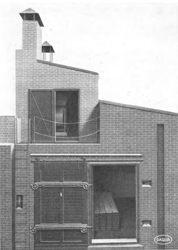
Abb. 762. Ansicht einer Kammertrockenanlage für Holz.
