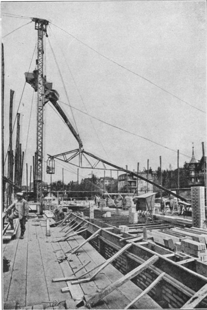
Abb. 13. Gießmasteanlage der Allied Machinery Co., Zürich.
