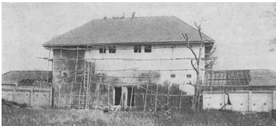
Abb. 7. Ansicht des Doppelwohnhauses für die N.I.S.E. in Priok.
