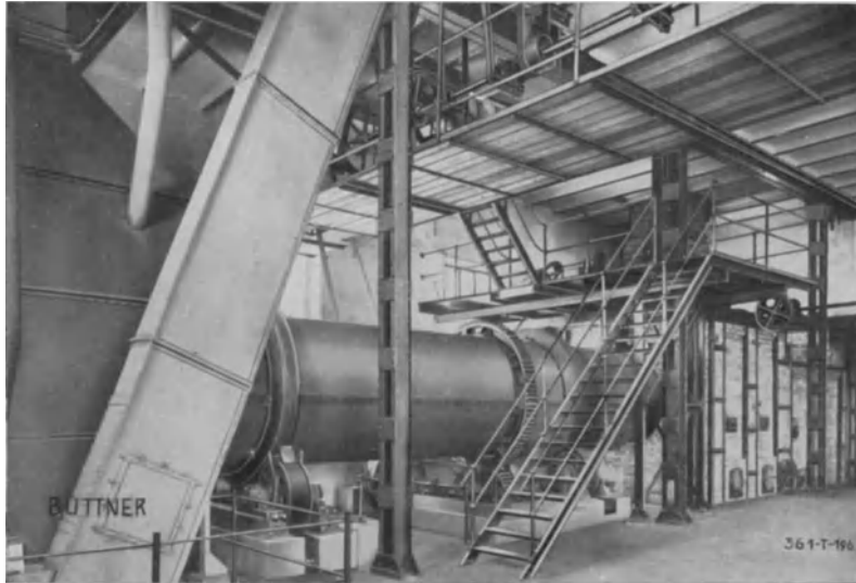
Abb. 5. Büttner-Trocknungsanlage für Rübenblätter.
