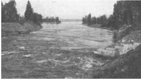
Abb. 122. Untra. Blick vom Kraftwerk auf den Unterkanal. (Verf.)
