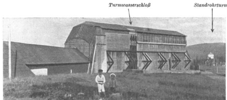
Abb. 101. Ljungawerk. Ansicht der Wasserschlößer. (Verf.)
