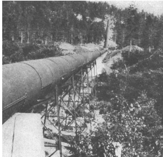
Abb. 774. E. W. Kristiansund. Rohrbrücke. (Verw.)
