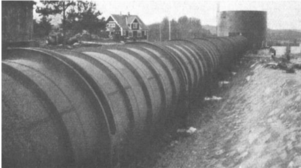
Abb. 758. Haby. Weitspannrohrleitung. (Vattenb. Byrån.)
