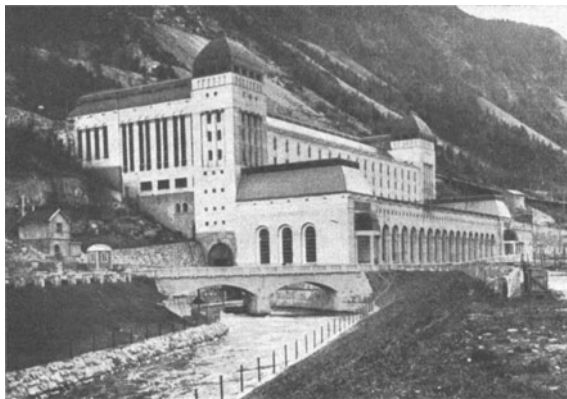
Abb. 437. Rjukan II. Ansicht des Kraft- und Ofenhauses. (Verf.)
