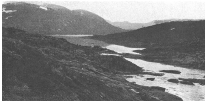
Abb. 299a. Storglomvand-Wehrbaustelle. (Norsk Vandb. Kont.)
