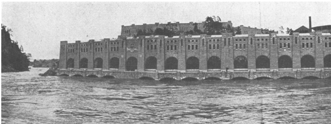
Abb. 207. Trollhättan. Unterwasseransicht des Kraftwerks. (Verw.)
