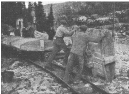
Abb. 948. Nore-Stollenbau. Flachmuldenkipper. (Verf.)
