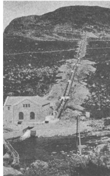
Abb. 760a. Glomfjord. Bandagenrohr (Ferrum 1917). Abb. 760b. Ryfylke. Oberes Werk. (Verw.)
