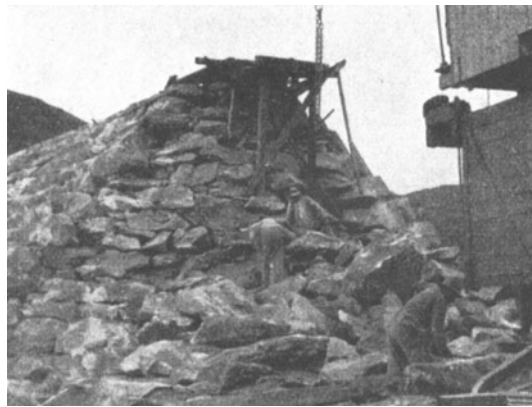
Abb. 600. Herstellung des Trockenmauerwerks. Abb. 599—600. Tarlebömauer. (Bonde.)
