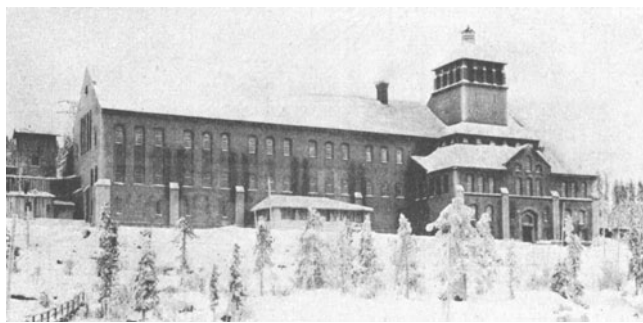
Abb. 866. Porjus. Schalthaus. (Verw.)
