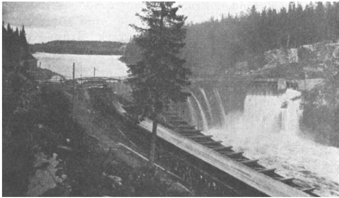
Abb. 87. Gideåbakka. Wehranlage bei Hochwasser. (Vattenbyggnadsbyrån.)
