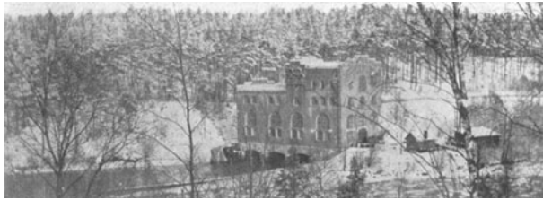
Abb. 247. Majenfors. Krafthaus, Unterwasseransicht. (Verw.)
