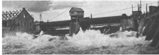
Abb. 211. Lilla Edet. Unterwasseransicht des Walzenwehres. (Verf. 1926.)
