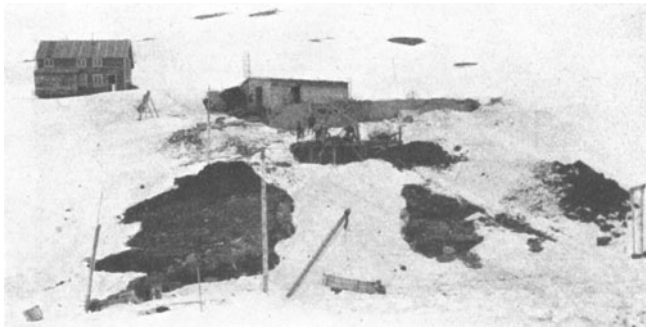
Abb. 932. Övre Breidalsvand 31. 5. 1924. Schnee- und Sandtransport. Baufläche zur Beschleunigung der Schneeschmelze mit Erde bestreut.
