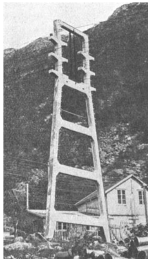
Abb. 982—983. Glomfjord. Eisenbeton-Trag- und Abspannmast. (Verw.)
