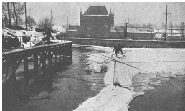
Abb. 985. Eisabweissteg und Eisschützen im Wasserschloß Trollhättan. (Verw.)
