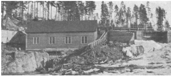
Abb. 93. Das provisorische Kraftwerk Stadsförs. (Vattenfallstyrelsen.)
