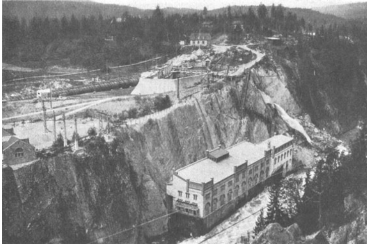
Abb. 457. Svålgfos. Kraftwerk I im Bau. (Kloumann.)
