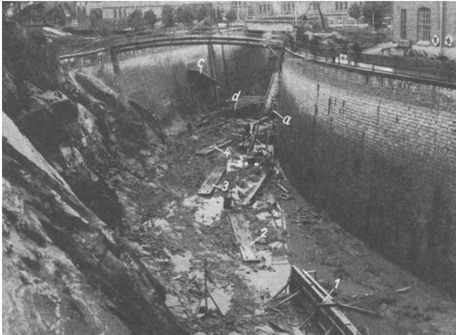
Abb. 751. Blick in den entleerten O.-Kanal beim Einbauen.
