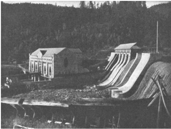
Abb. 439. Lienfos. Unterwasseransicht. (Verf.)
