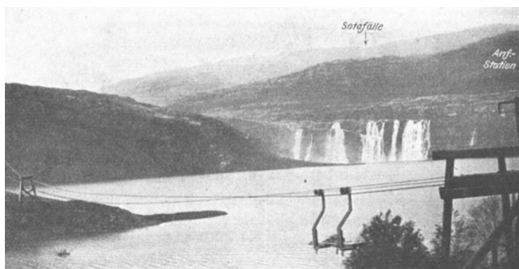
Abb. 925—926. Fiskevandsperrre. Schwebebahn von unterer Endstation aus. (Verf.)
