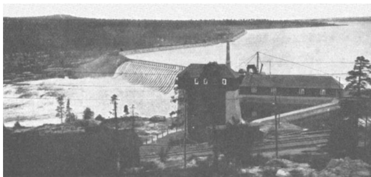
Abb. 56. Porjuswerk: Überfall mit aufgestelltem Nadelwehr. (Verf.)
