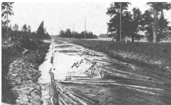
Abb. 924. Triftkanal anschließend an Abb. 923. Blick stromab. (Verf.)
