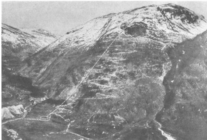
Abb. 358. Tyin. Kraftwerksgelände. (Verw.)
