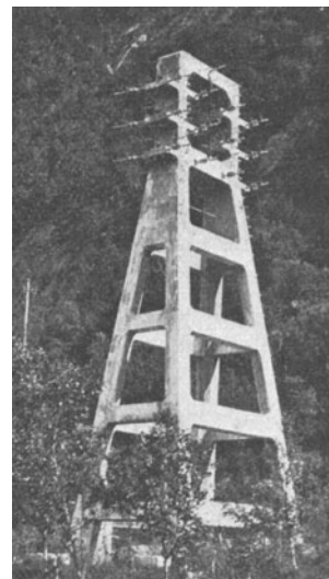
Abb. 982—983. Glomfjord. Eisenbeton-Trag- und Abspannmast. (Verw.)
