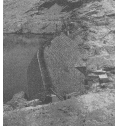
Abb. 599. Überblick nach Fertigstellung.
