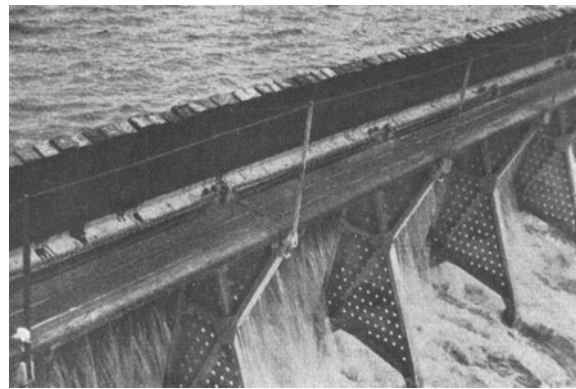
Abb. 670. Porjus. Nadelwehrböcke aus Stahlblech gepreßt. (Baumgarten.)
