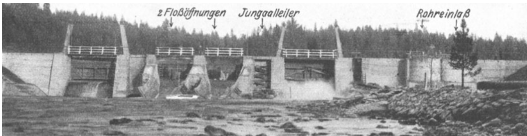
Abb. 146. W. A. Skattungby. Regulierungswehr, Unterwasseransicht (Vattenbyggnadsbyrån.)
