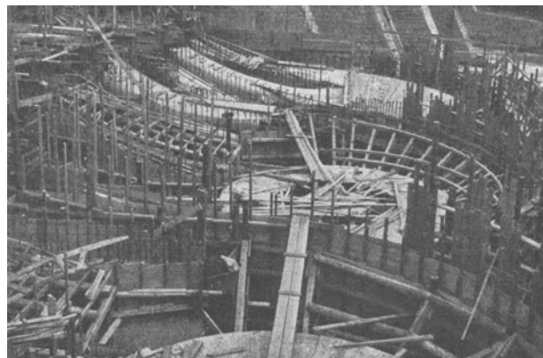
Abb. 850. Forshuvudforsen. Kraftwerk, Baustelle. (Verw.)
