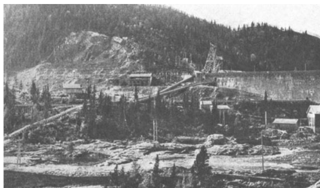
Abb. 464. Nore. UW.-Ansicht der Tunhövdsperrre mit Baukraftwerk und Floßbrinnen. (Verf. 1921.)
