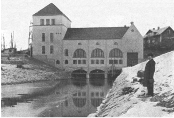
Abb. 156. Öjebro. Krafthaus, Unterwasser-Ansicht. (Vattenbyggn. Byr.)
