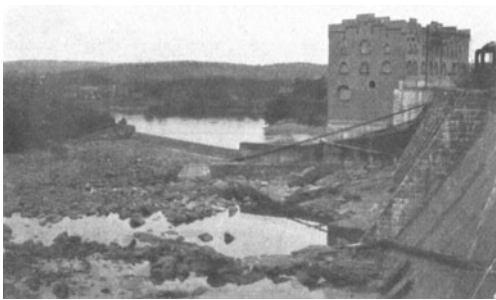
Abb. 248. Övre Knäred. Wehrunterwasser (mit Kolk) und Krafthaus. (Verf.)
