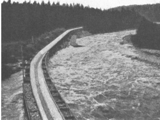
Abb. 922. Gideåbacka. Einmündung der Triftrinne in das Kraftwerks-U.-W. (Verf.)
