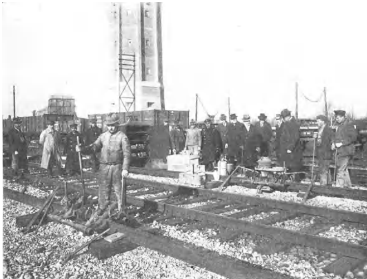
Abb. 96. Schienenschweißung.
