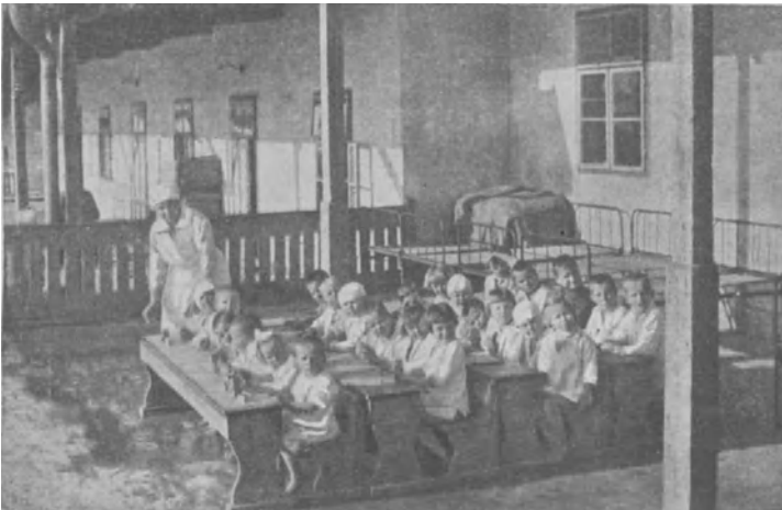
Abb. 94. Kindergarten im Freien
