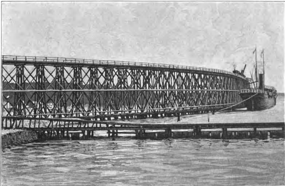
423. Eisenverladebrücke am Hafen von Lulea (Schweden).
