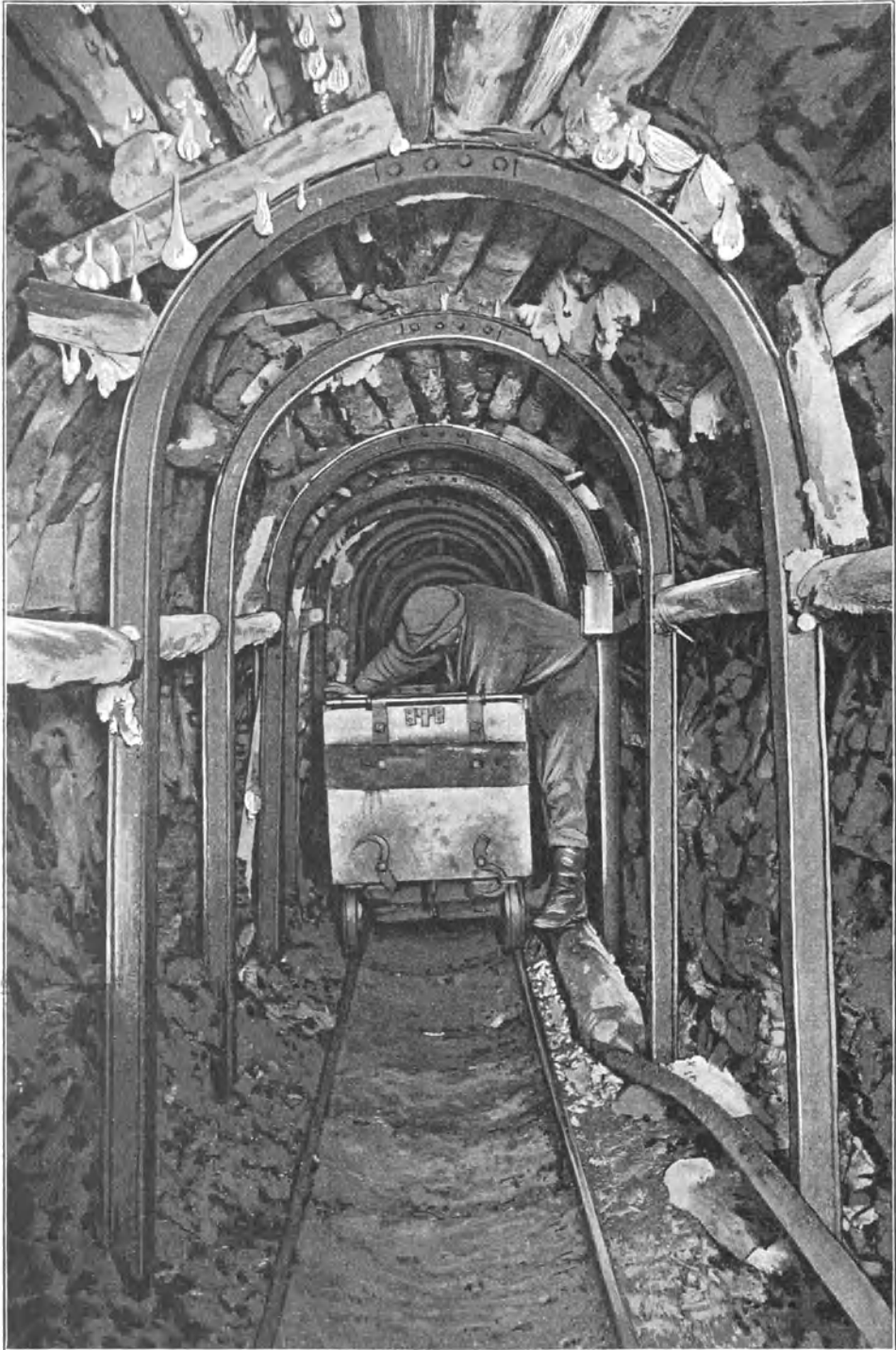
138. Förderstrecke in Eisenausbau. Originalaufnahme von Börner.
