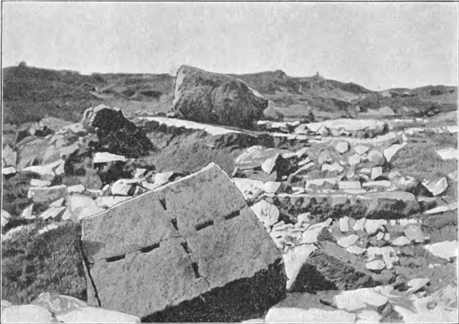
10. Bearbeitung des Granits in altägyptischer Zeit. Granitblock mit Steinlöchern in einem Steinbruche bei Assuan.
