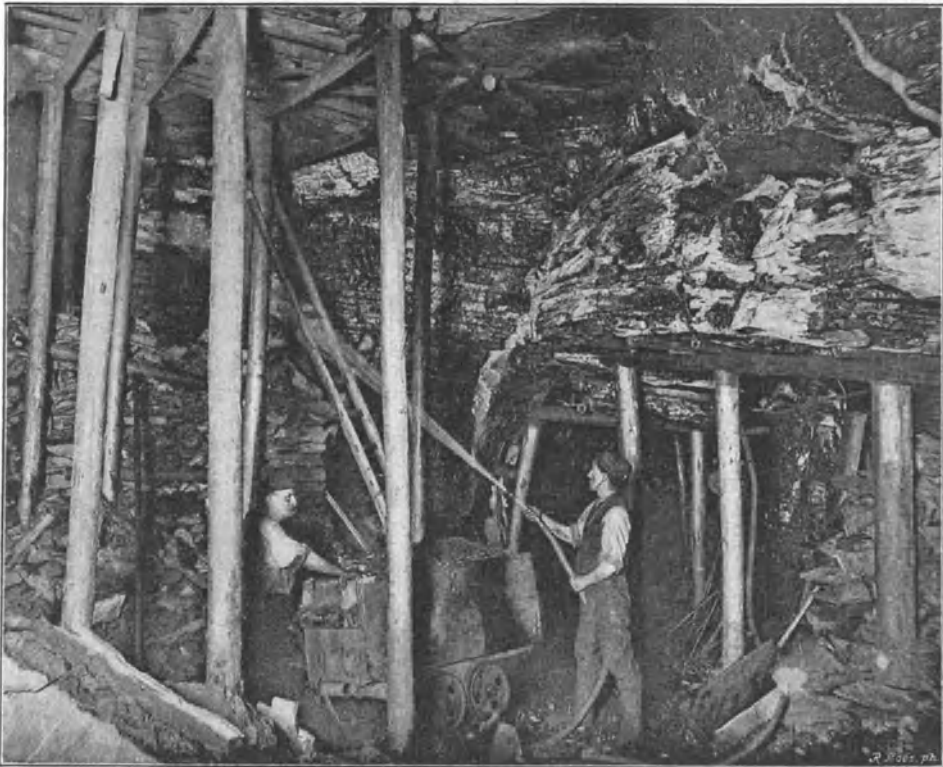
277. Heizung des Kohlenstaubes. Nach Börner u. Geogrt, „Der Kohlenbergmann“ Verlag Graz u. Gerlach, Freiberg.
