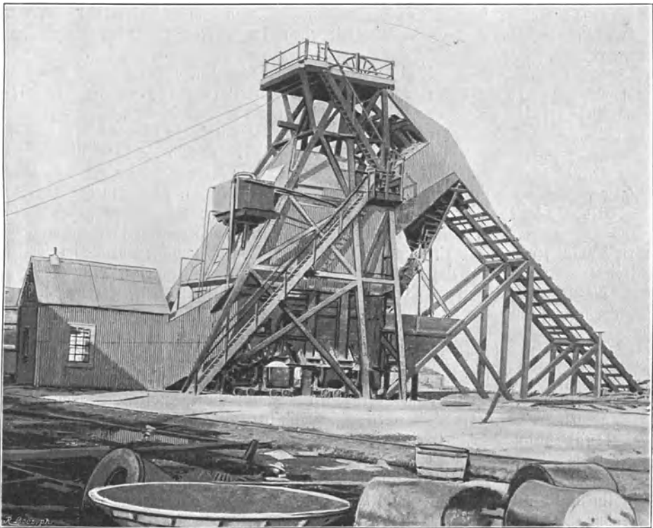
195. Heilscheibenstuhl des Hauptstachtes der May Consolidated Co. bei Johannesburg. Bergbau
