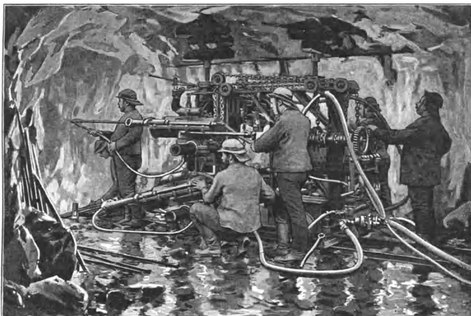
181. Bohrgerüst für vier Meyersche Gesteinsbohrmaschinen.
