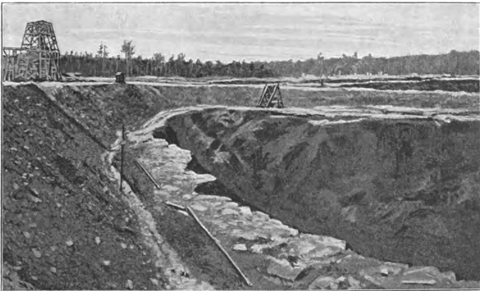
420. Trichterbau auf der Grube Auburn (Minnesota).
