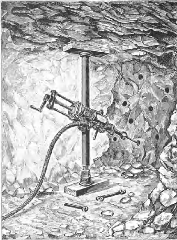
130. Schraubenspannsäule mit Meyerscher Gesteinsbohrmaschine.
