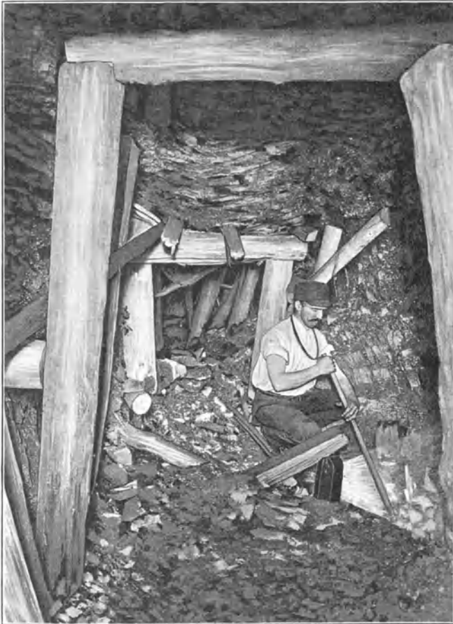
274. Wiederaufbau einer verdrückten Strecke.
