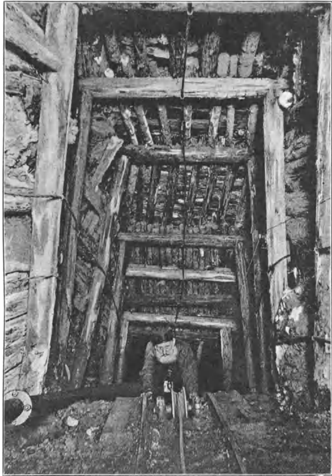
137. Thürstockzimmerung in einem Fallorte. Nach Börner, „Der Kohlenbergmann in seinem Beruf.“
