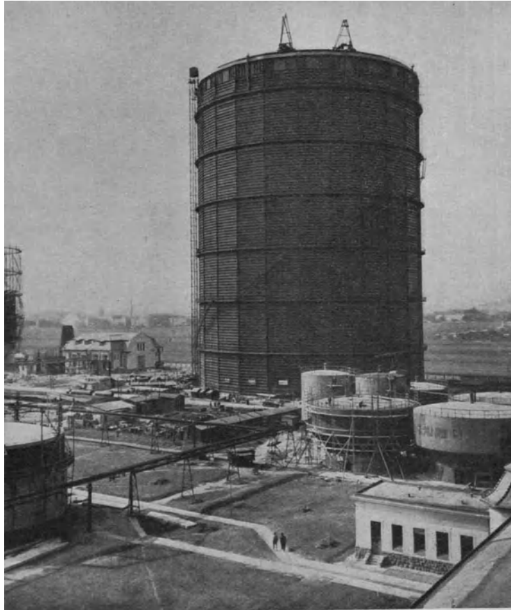
Abb. 7. Werk Leopoldau; der im Jahre 1930 in Betrieb gegangene Scheibengasbehälter von 300 000 m 3 Nutzinhalt. Links oben der alte Gasbehälter; links vorne Behälter für Generatorgas, rechts Behälter für Teer und Ammoniakwasser.
