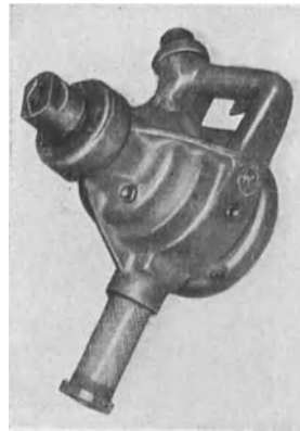
Abb. 192. Ansicht einer Flottmann-Freihand-Bohrmaschine.
