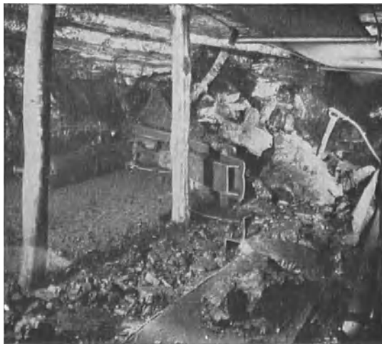
Abb. 171. Blick auf Hammzylinder und Pflugschar des Kohlenpfluges.
