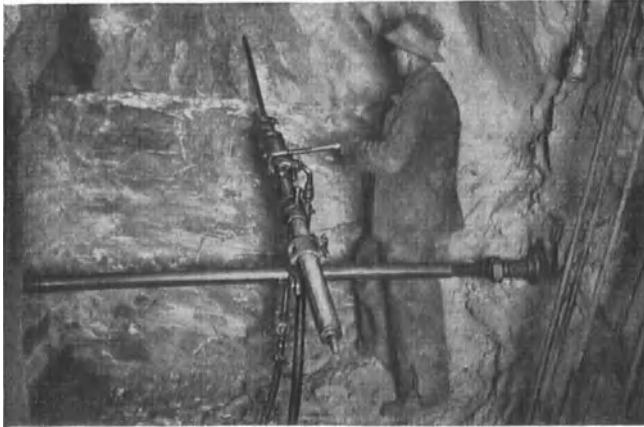
Abb. 216. Demag - Einspannvorrichtung.
