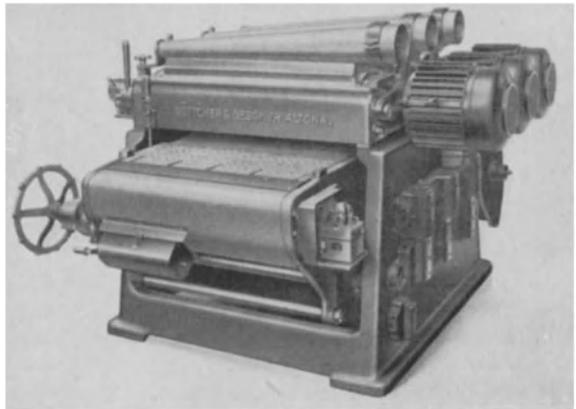
Abb. 67. Schwere Dreitrommelschleifmaschine (Böttcher & Gessner).
