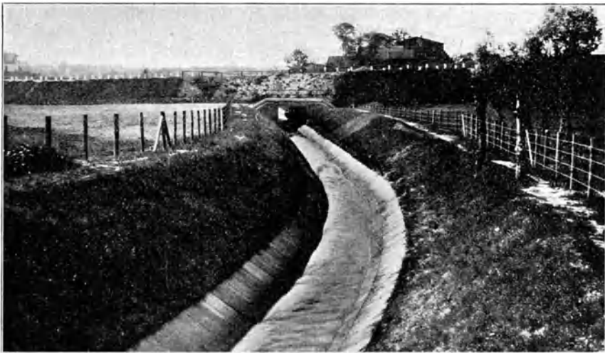
Als offener Abwassergraben ausgebaute Vorflut im Emscherg Gebiet (Emschergenossenschaft, Essen).
