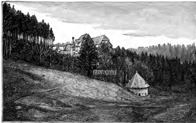
Biologische Tropfkörperanlage für die Lungenheilstätte der Invaliditäts- und Altersversicherungsanstalt des Grossherzogtums Baden Luisenheim bei Marzell im Schwarzwald. Etagentropfkörper System Schweder, Sommer 1905 errichtet. Tägliche Abwassermenge 50 cbm.
