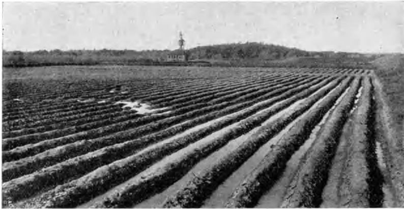
Staufferfiltration in Brockton (Nord-Amerika) während des Winterbetriebes, nach Henneking.
