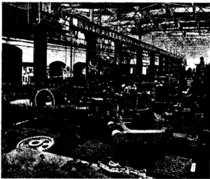
Рис. 10. Рулевая рама, весом в 22 тонны, отлитая на заводе Шкода.
