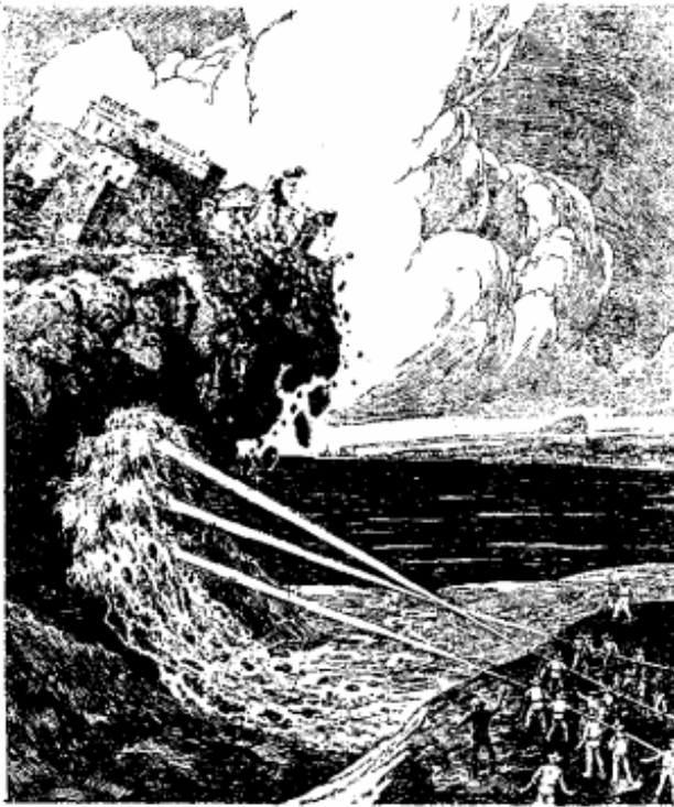
Рис. 57. Размыв холма гидравлическим способом.
