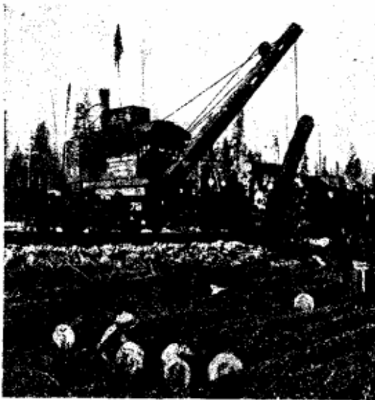
Рис. 43. Паровой кран на жел.-дор. платформе.
