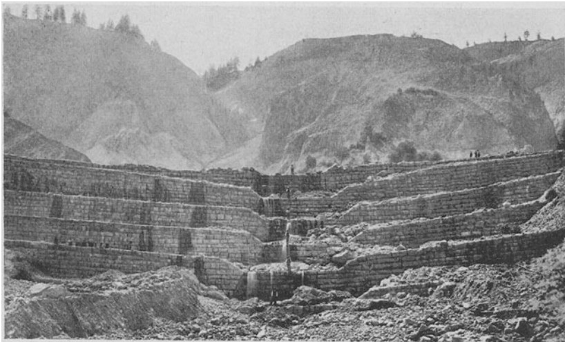
Abb. 40. Unvollendete Sperrenserie im obersten Bruchkessel des Schesatobels bei Bludenz.
