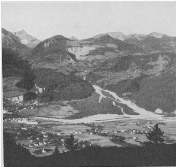
Abb. 2. Gesamtansicht des Schesatobels bei Bludenz.
