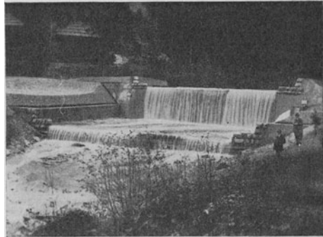
Abb. 65. Sperre mit Tosbecken, Vordernbergerbach im Gailtal, Kärnten.
