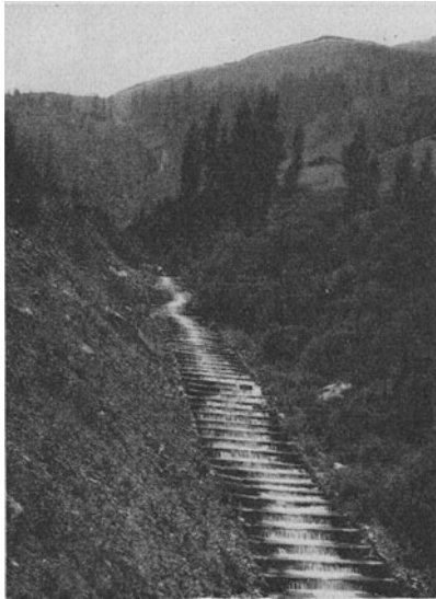
Abb. 77. Abtreppung mittels Prügelsperren, Riedbach, Zillertal.
