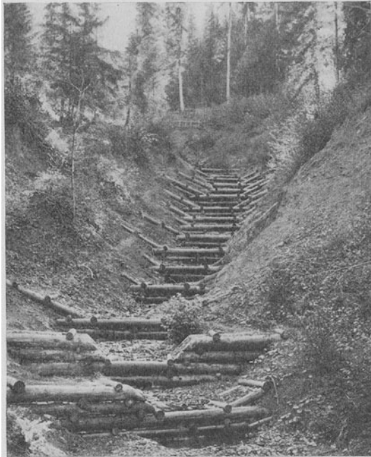
Abb. 33. Abtreppung mit hölzernen Grundswellen, Klempferergraben bei St. Johann i. T.
