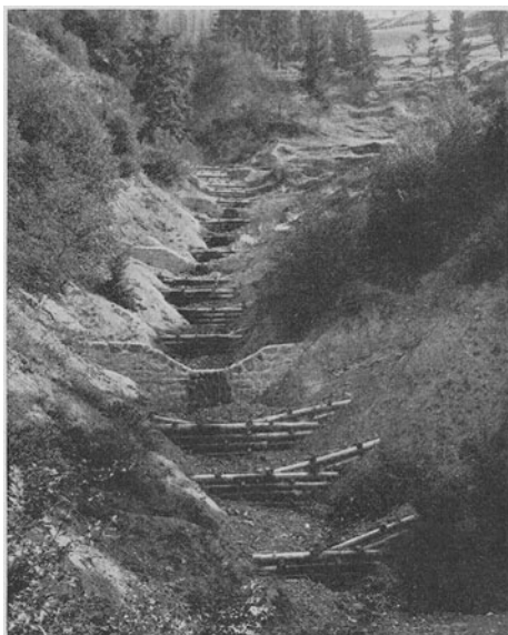
Abb. 29. Verbaute Grabenstrecke, Meßnergraben bei Hopfgarten, Nordtirol.
