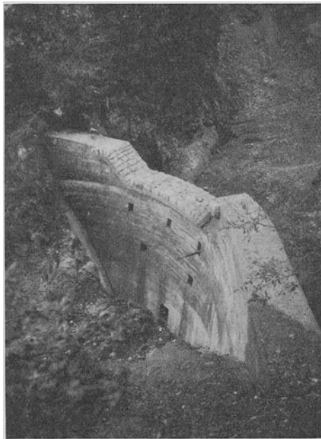
Abb. 42. Betonsperre, Galgentobel bei Bludenz, Vorarlberg.
