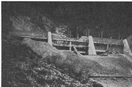
Abb. 89. Eisenbetonsperre, System Lenz-Braun, Winklergraben, Salzkammergut.
