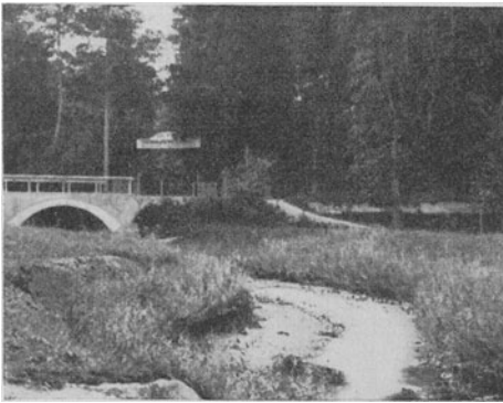
Abb. 120. Lebende Uferschutzbauten, Traunkirchner Mühlbach, Ob. Österreich.
