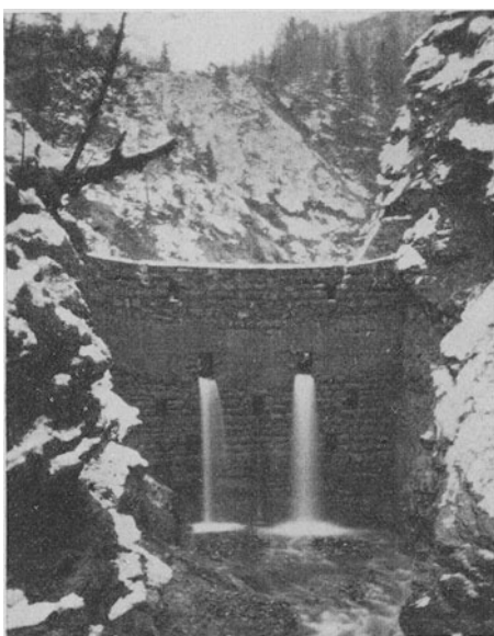
Abb. 20. Stausperre im Frödischbach, Vorarlberg.
