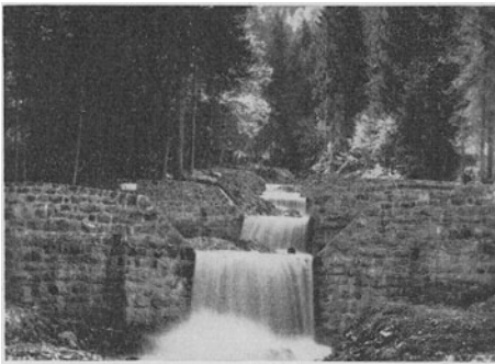
Abb. 56. Abtreppung mittels gemauerter Sperren, Zwerenbach, Vorarlberg.
