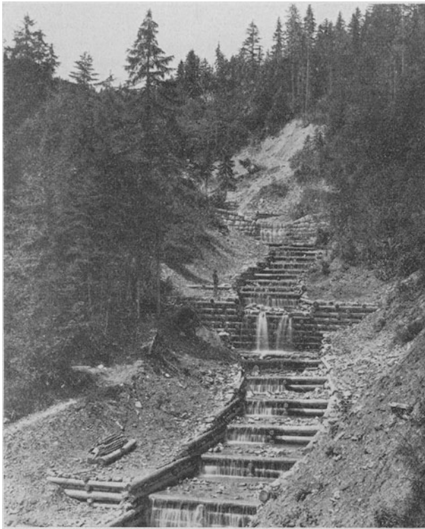
Abb. 32. Abtreppung und Uferschutzbauten, Hinterer Glaselbach, Gosau, Ober-Österreich.
