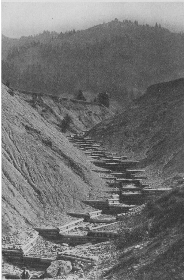
Akb. 25. Abstufelung mit Holzschwellen, Gunzmoosriese bei Dornbirn, Vorarlberg.
