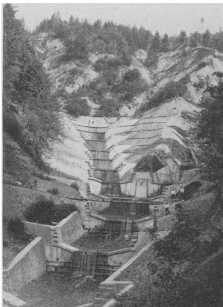
Abb. 31. Sperren in Stampfbeton, Schief- lingbach am Ossiachersee, Kärnten.
