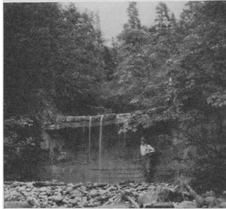
Abb. 61. Betonsperre mit Wassernase, Gunzmoosriese bei Dornbirn, Vorarlberg.
