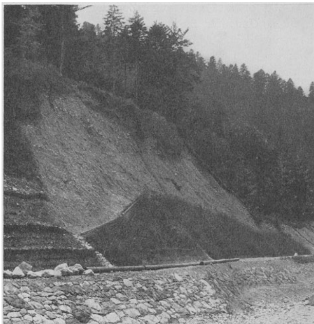
Abb. 129. Begonnene Lehnenbindungsarbeiten, Langbathbach, Ob. Österreich.
