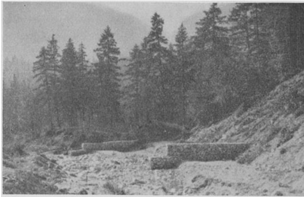
Abb. 135. Spornbauten mit Drahtschotterbehältern, Röthgraben, Frauenweißenbach, Salzkammergut.
