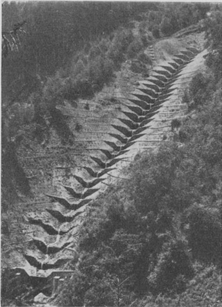
Abb. 23. Sohlenabtrepfung, Rabenbach am Ossiachersee, Kärnten.
