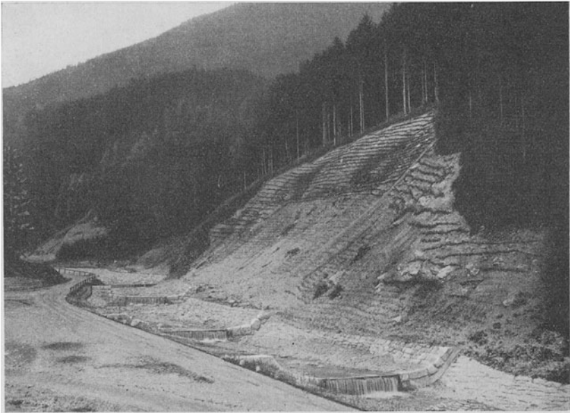
Abb. 27. Uferschutzbauten und Bruchflächensicherung, Langbathbach bei Ebensee, Ob. Österreich.
