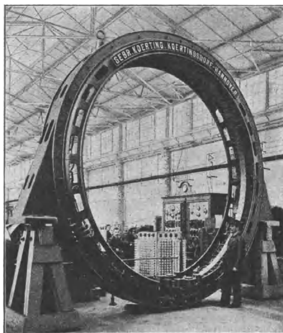
Fig. 90. Mehrpolige Schwungradbremse von Körting, zwischen den Schildern des Induktoringes eingebaut.
