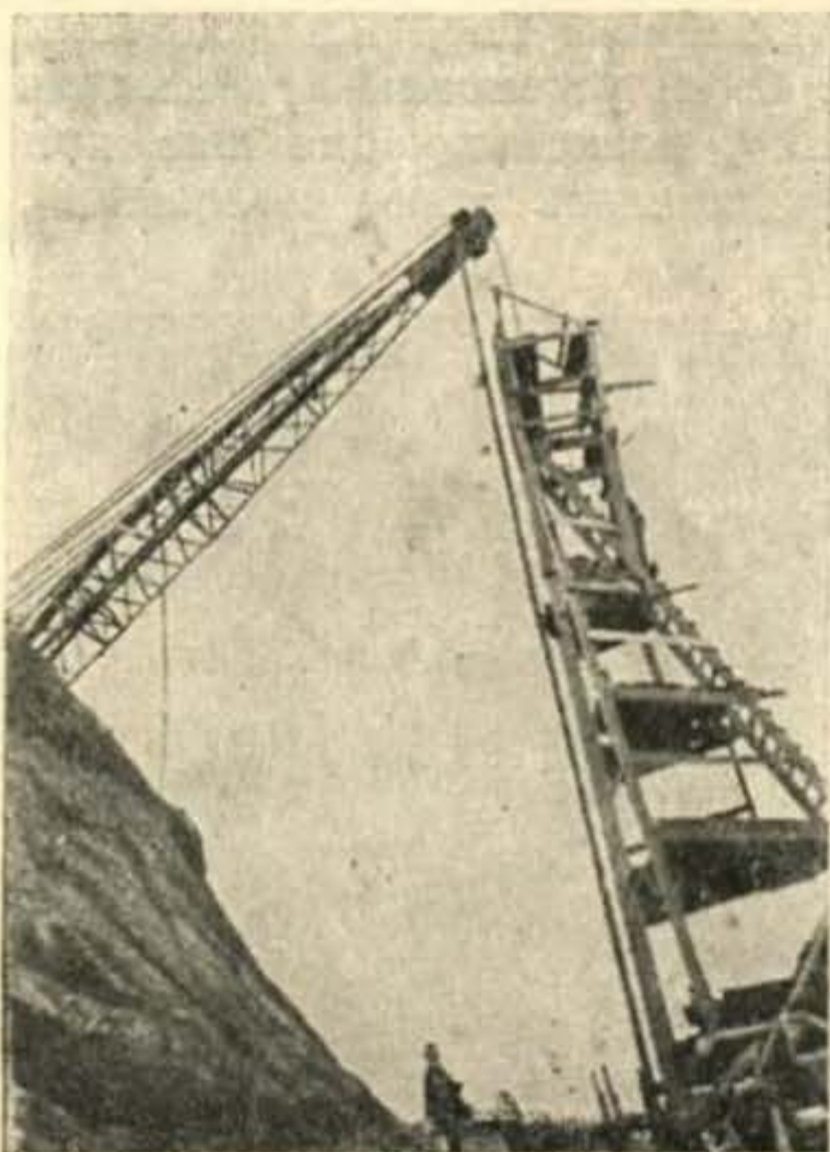
Фиг. 65. Установка шпунта с помощью экскаватора
