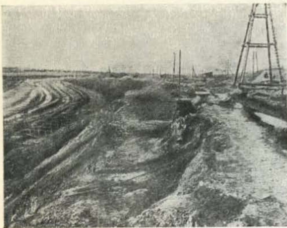
Фиг. 93. Скважины глубинного водоотлива, расположенные на бровке
