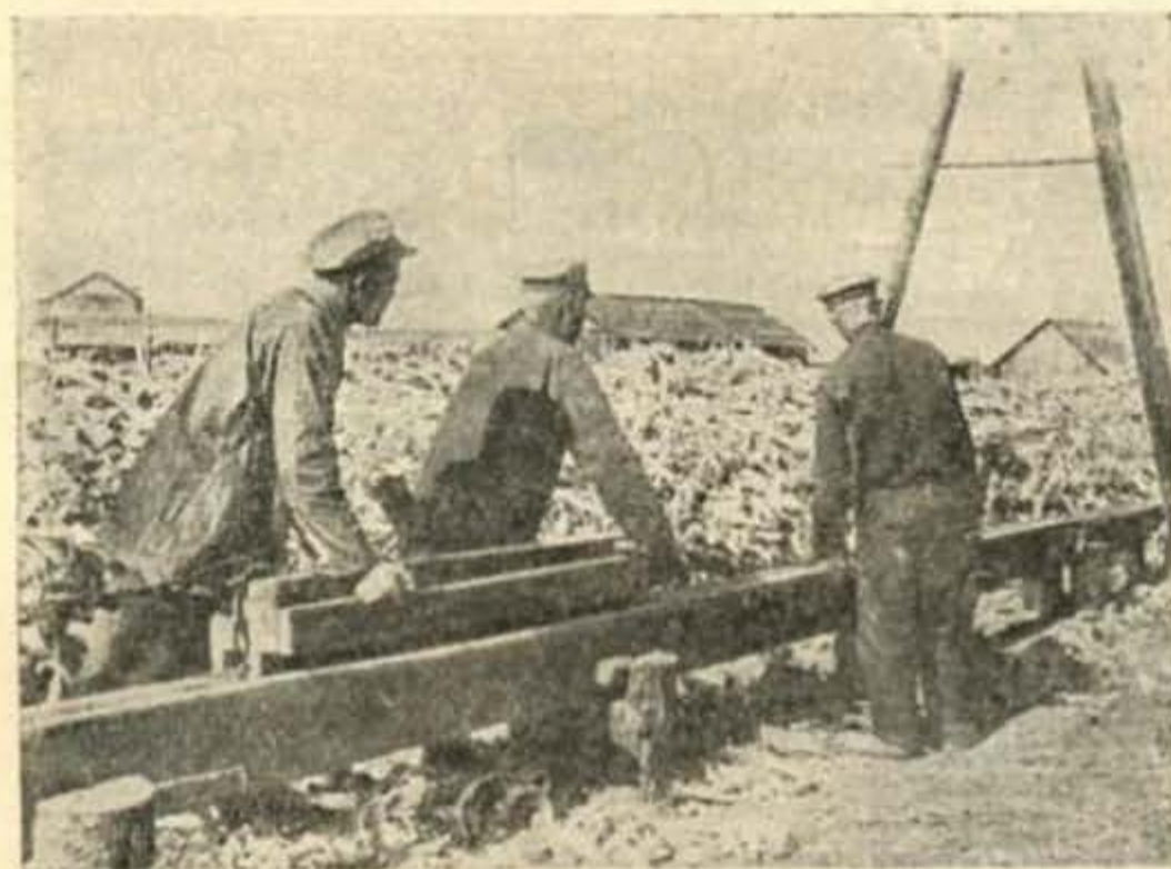
Фиг. 34. Изготовление шпунтин фигурным фуганочным станком с конной тягой
