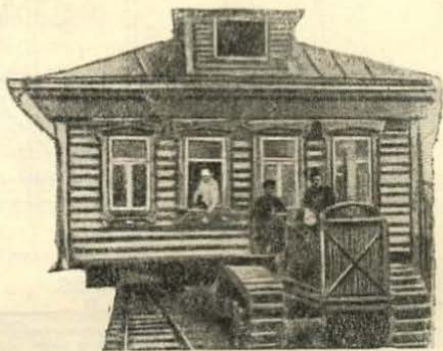
Фиг. 119. Дом на платформе перевозится на новый участок
