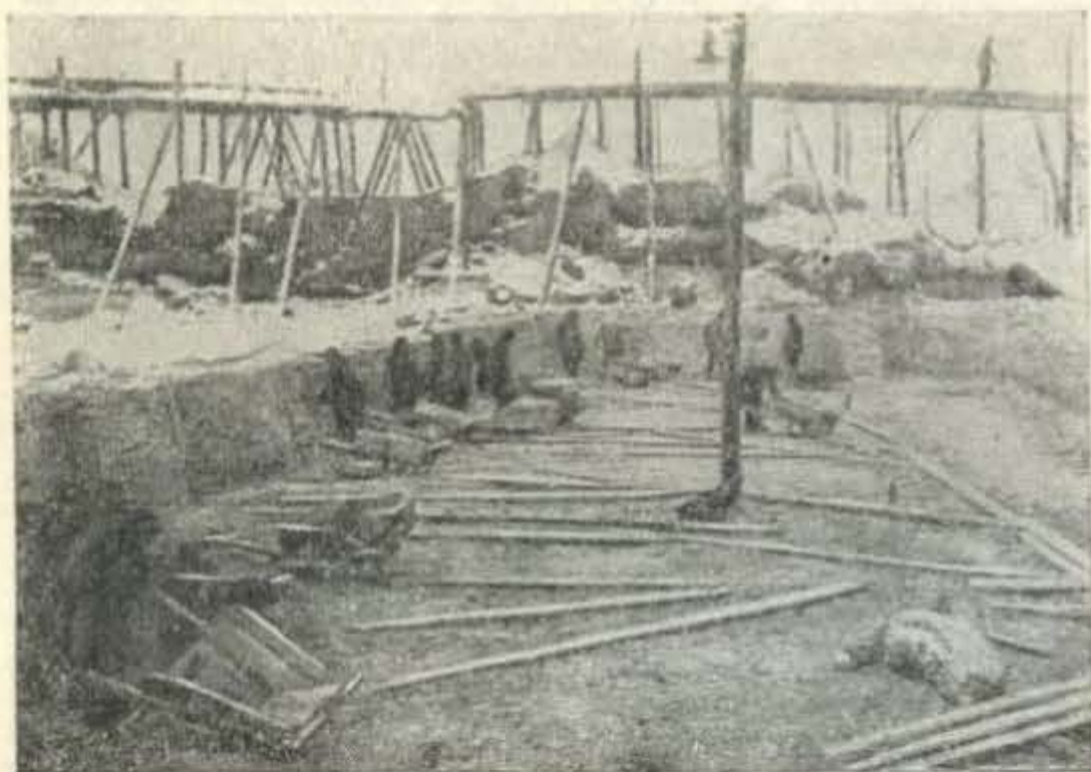
Фиг. 85. Разработка обезводненных пльвущих аптских песков в камере шлюза
