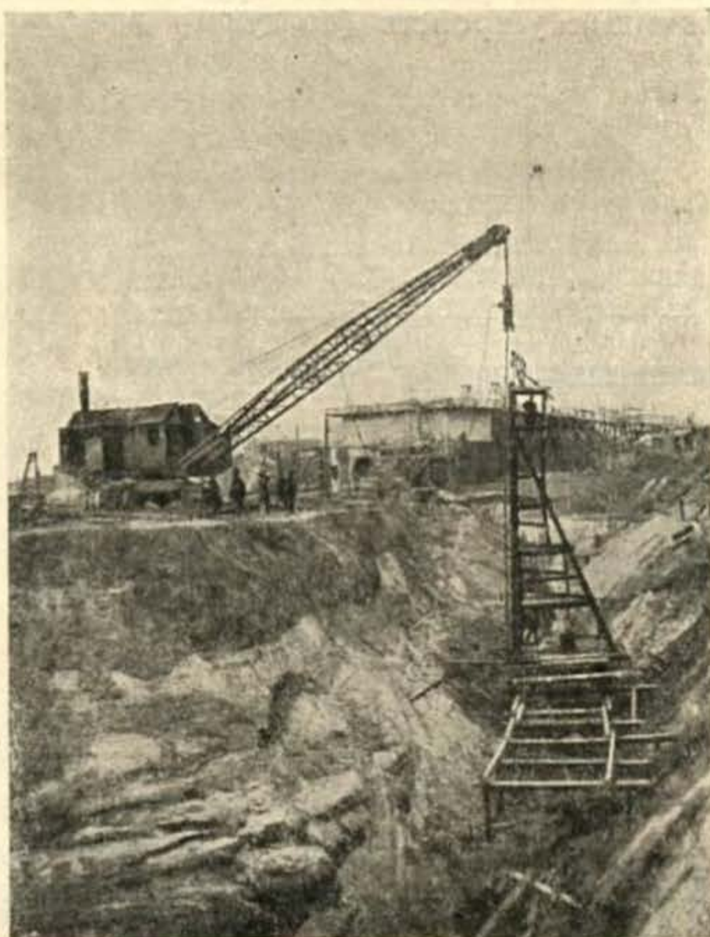
Фиг. 67. Подводка и установка молота
