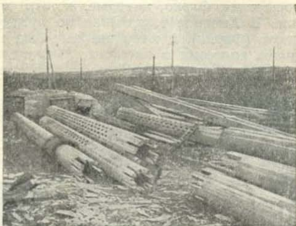
Фиг. 81. Изготовление деревянных фильтровых труб для глубинного водоотлива
