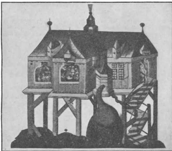
Abb. 52. Badehaus mit Heizung durch Dampf aus einem retortenförmigen Gefäß nach der Handschrift Bellifortis aus dem Anfang des XV. Jahrhunderts.
