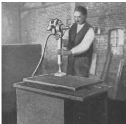
Abb. 101. Verdichtungsstamper zur Herstellung von Betonwaren. System: Robert Wacker, Dresden.
