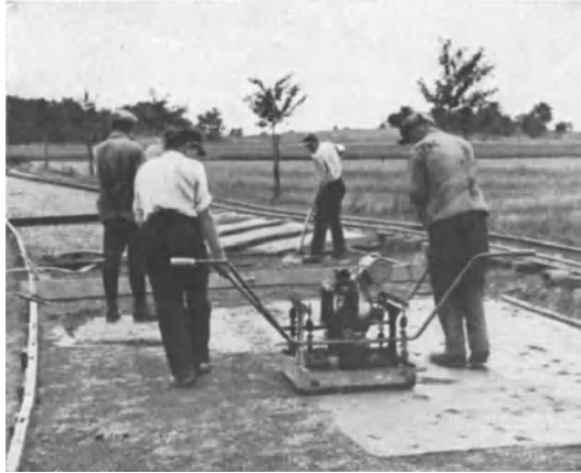
Abb. 98. Transportabler Rüttler für Straßenverfestigung. System: Heinrich Frisch, Augsburg.
