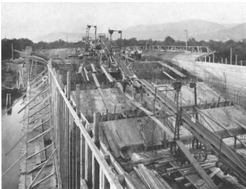
Abb. 89. Betonierung mit Förderbändern: Die Förderbänder laufen auf der zu betonierenden Brücke (vgl. Abb. 90) zur Verteilung des Betons.
