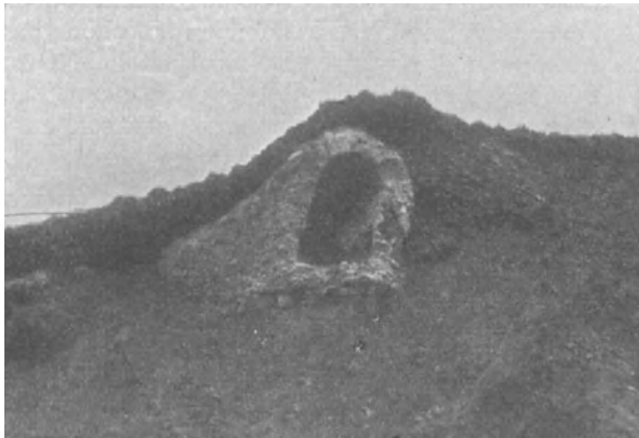
Abb. 1. Römische Wasserleitung aus der Eifel nach Köln, 1,50 m hoch, 100 km lang, erbaut um das Jahr 100 nach Christi Geburt, aus Romazementbeton.
