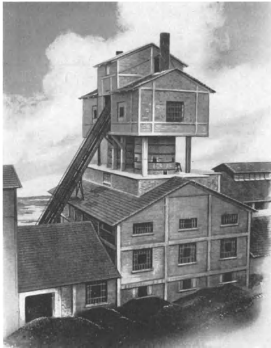
Abb. 24. Schachtofen mit mechanischer Austragung zum Brennen von Zement.
