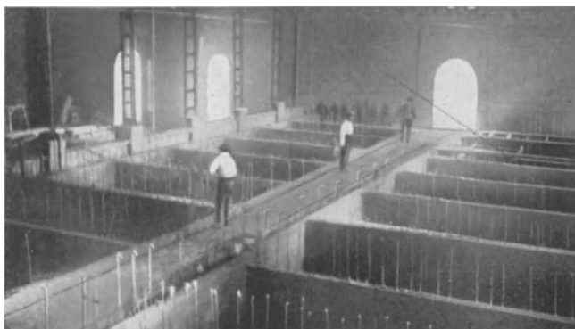
Abb. 202. Die Behälter von oben vor der Fertigstellung.
