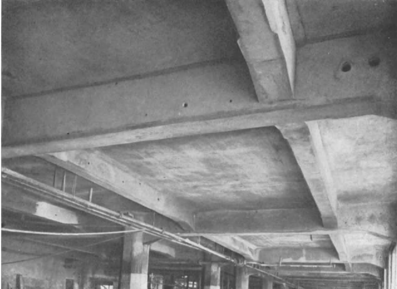
Abb. 250. Durch Spritzbeton (Moser-Kraftbau) wiederhergestellte Decke in der ausgebrannten Sarottfabrik.
