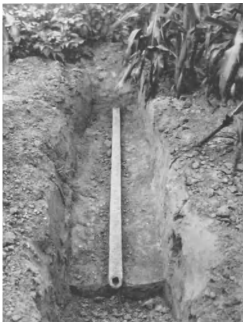
Abb. 147. In der Erde hergestelltes poröses Rohr für Drainage aus Beton.
