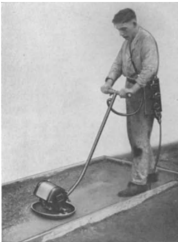
Abb. 97. Kleiner transportabler Rüttler für Verdichtung kleiner Betonplatten, wie Decken u. dgl. System: Losenhausen.
