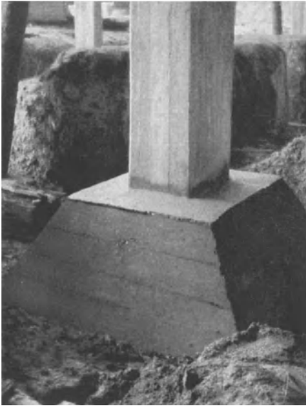
Abb. 261. Wiederhergestellter Pfeiler der Abb. 259.
