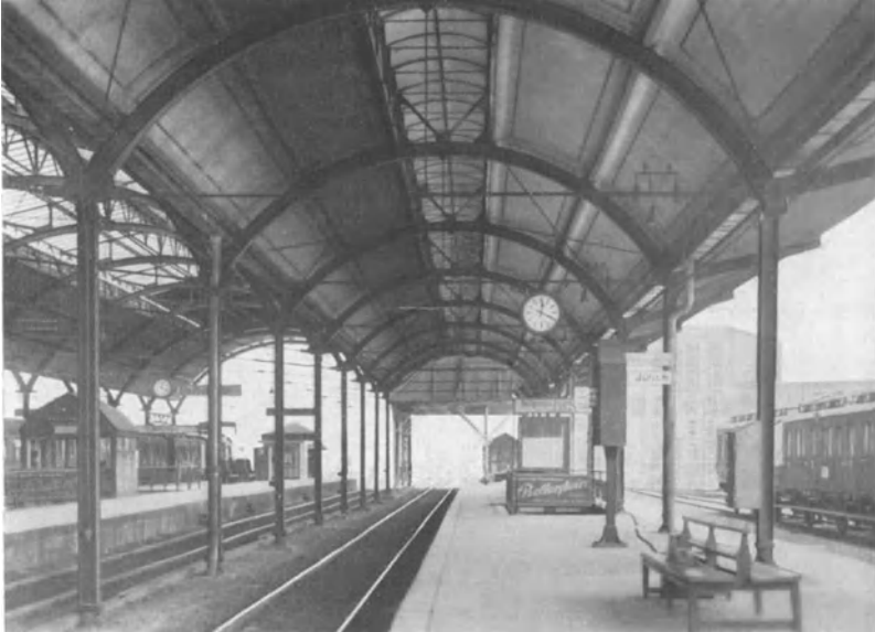
Abb. 246. Bahnhofshalle in M.-Gladbach vor der Torkretierung.
