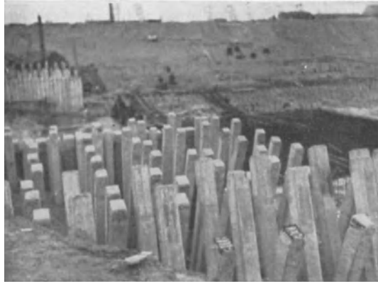
Abb. 153. Fertige Pfähle bei der Schleuse in Ymuiden.
