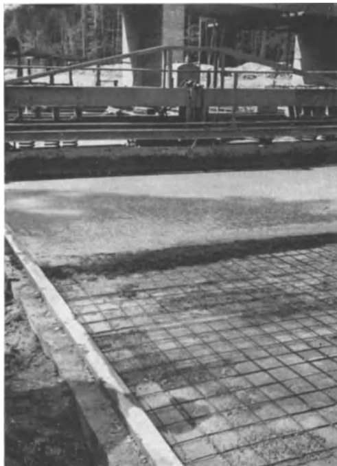
Abb. 105. Bohlenstampfmaschine: Im Vordergrund der verdichtete Beton, weiter vorne der Unterbeton und die darauf liegende Bewehrung punktgeschweißten Drahtgewebes.
