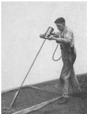
Abb. 100. Tauchrüttler zur Verdichtung von Beton, besonders in Säulen. System: Losenhausenwerk Düsseldorf
