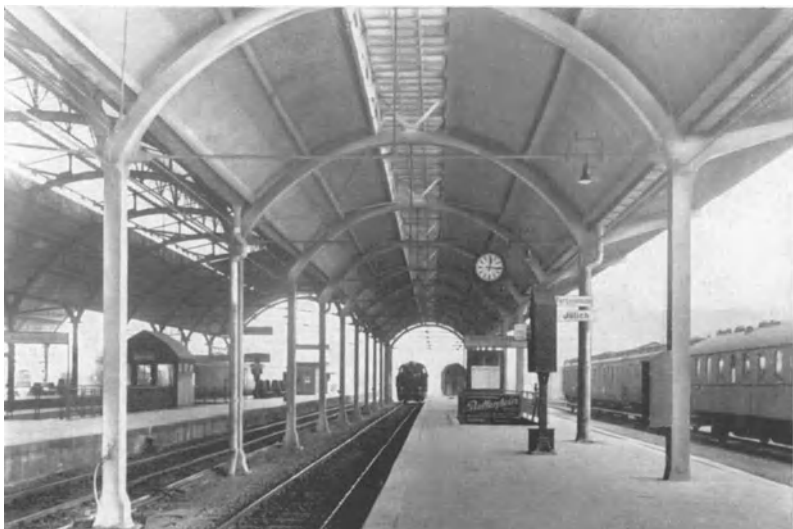
Abb. 247. Bahnhofshalle in M.-Gladbach nach der Torkretierung.
