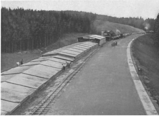
Abb. 169. Abdeckung des Frischbetons mit fahrbaren Dächern. Hier sind im Gegensatz zu Abb. 168 die Dächer dem Bauvorgang gefolgt.
