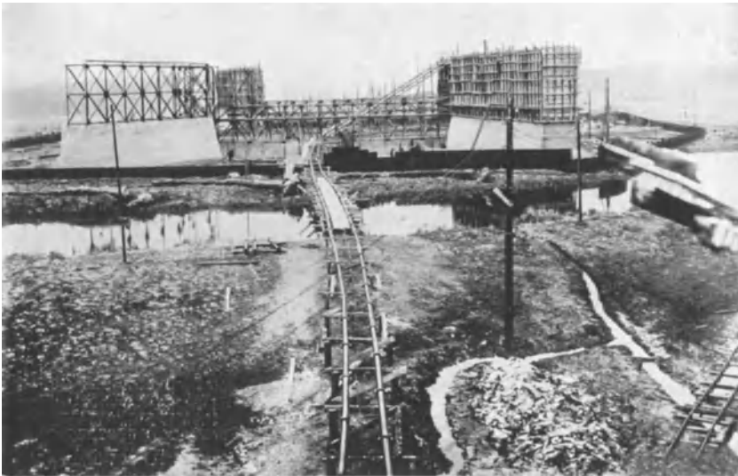
Abb. 85. Baustelle, bei der Pumpbeton in die Schalung gefördert wird. Im Vordergrund die beiden Rohrleitungen für Beton.
