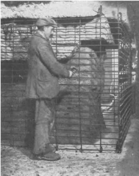
Abb. 257. Umgebung eines durch Salzwasserwirkung beschädigten Fundaments nach Entfernung der mürben Anteile mit einem Drahtgeflecht vor Aufbringung des neuen Hochofenzementbetons. (Aufn. G o e b e l, L'hafen.)
