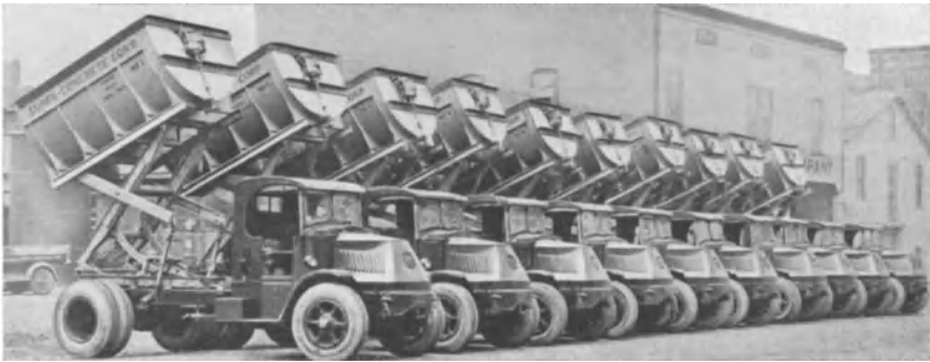
Abb. 93. Transportwagen, die den Beton während der Verbringung dauernd in Bewegung halten, um Entmischung zu verhindern.
