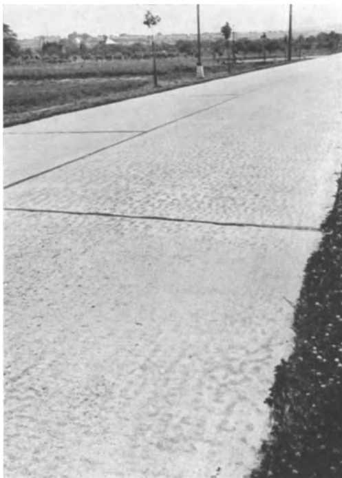
Abb. 30. Oberfläche einer Betonstraße, die unter Verwendung von bituminierem Zement hergestellt wurde. Der Zement ist gut erhärtet, die Wasserabweisung des Zementes während des Erhärtens hat aber zu einer Oberflächenveränderung geführt.
