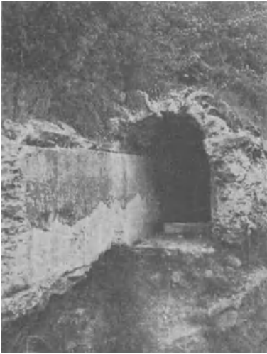
A) Ansicht in die aus Beton hergestellte, etwa 80 km lange Wasserleitung aus der Eifel (Sötenich) nach Köln, die ungefähr 70 n. Chr. erbaut wurde. Boden und Seitenwände sind aus Felschlagbeton mit Sandzusatz, der Überzug ist ein Putz von Ziegelmehl. Bindemittel: hydraulischer Kalk.
