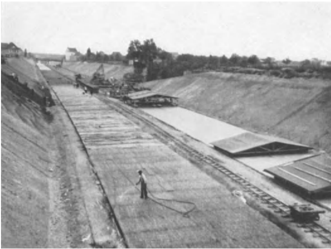
Abb. 168. Betonstraße: Links lange Zeit nach der Herstellung mit Strohmatte belegt (zweckmäßig), rechts kurz nach der Herstellung mit an den Seiten und an den Stirnwänden nicht abgedichteten Dächern. Die Dächer sind dem Bauvorgang nicht schnell genug gefolgt. Infolgedessen trocknet der Beton zu stark aus und bekommt jetzt Schwindrisse.
