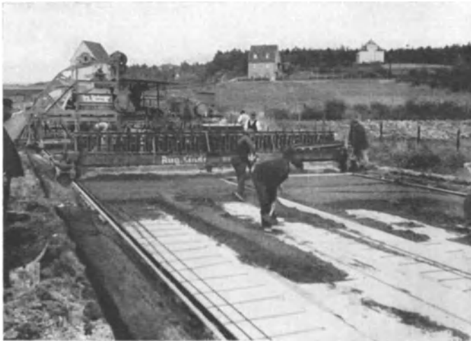
Abb. 104. Stampfmaschine der Abb. 103 in Tätigkeit: Im Vordergrund sieht man die Aufbringung des Betons auf die Papierunterlage, die Eisenbewehrung und die Vorrichtung der Fugen.
