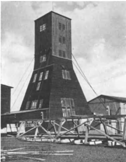
Abb. 91. Heranbringung des Zuschlagsstoffes mit Schüttelrinnen bei einer Schachtabteufung unter gleichzeitiger Erwärmung des Zuschlags durch Holzfeuer unter der Schüttelrinne.
