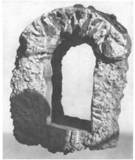
Abb. 4. Stück aus der ungefähr 80 km langen Wasserleitung von der Eifel nach Köln, erbaut von den Römern 70—90 n. Chr. Beton aus Kies in Korngrößen, die den Eisenbetonbestimmungen von 1933 entsprechen, mit hydraulischem Kalk als Bindemittel.
