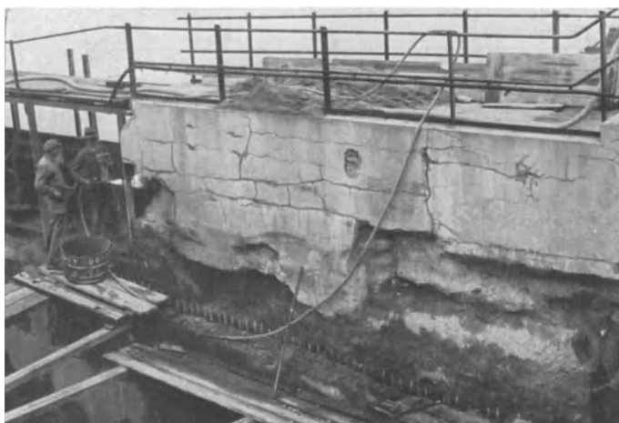
Abb. 251. Wiederherstellung einer durch Frost und chemische Einflüsse zerstörten Betonmauer eines Wasserkraftwerkes durch das Moser-Spritzverfahren.
