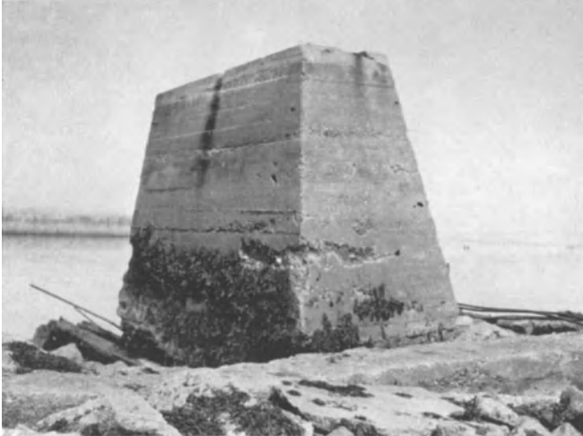
Abb. 102. Drahtseilbahnfundament von Helgoland in Zerstörung begriffen durch Meerwasser-einwirkung: Die bei der Herstellung vor 20 Jahren schlecht gestampfte Ecke ist der Ausgangspunkt der Zerstörung.
