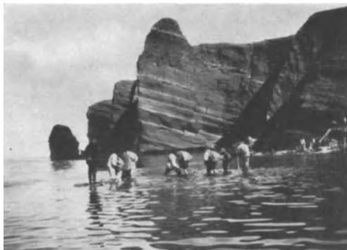
Abb. 128. Einbringen von Sackbeton.
