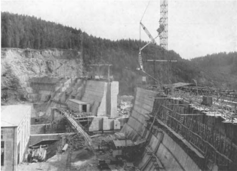
Abb. 81. Ansicht einer Gußbetonanlage mit dem eingebauten Gießturm.
