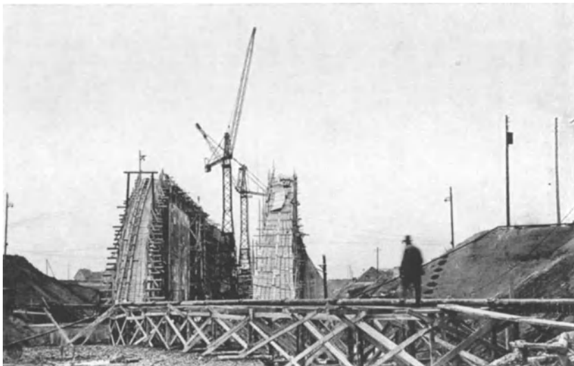
Abb. 86. Einbringung von Pumpbeton (links durch die Rohrleitung) in die Schalung. Die Schalung wird mit Turmdrehkran verlegt.
