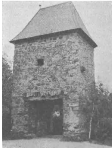
B) Stadttor in Rheinsberg. Durchweg erbaut aus Betonblöcken, die aus der Wasserleitung (Bild 1) ungefähr im 10. oder 11. Jahrhundert herausgestemmt wurden. Trotz der fast 1000 jährigen Beanspruchung durch Klimateinflüsse hat sich der ursprünglich gar nicht für Außenlagerung, sondern für Unterbau bestimmte Beton ohne Verputz überraschend gut gehalten.
