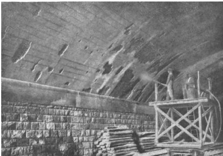
Abb. 244. Wiederherstellung beschädigter Behälter mit dem Torkretspritzverfahren.
