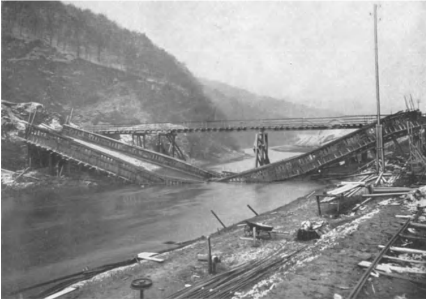
Abb. 167. Brücke von Abb. 166 nach der Entschalung, zusammengestürzt infolge ungünstigem Korngrößenverhältnis des Basaltsplittbetons und infolge falscher Reihenfolge beim Entschalungsvorgang.
