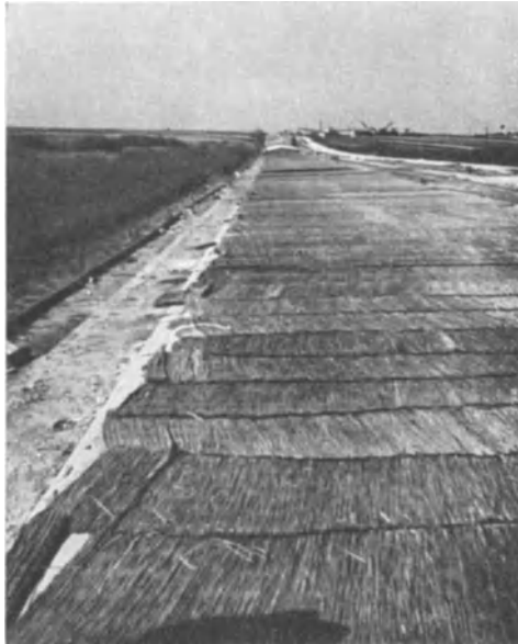
Abb. 170. Abdeckung mit Schilfmatten, die neuerdings für zweckmäßiger als die Dachabdeckung gehalten werden, da kein Zug entstehen kann.
