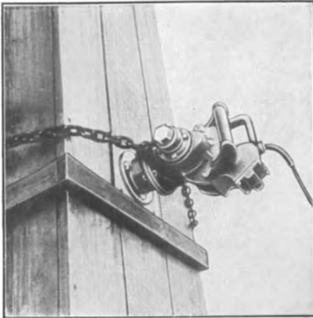
Abb. 96. Rüttelmaschine zur Erschütterung der Schalung. System: Robert Wacker, Dresden.
