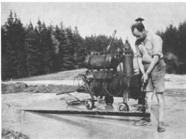
Abb. 120. Herauslösung der vor dem Einbetonieren mit Pech angestrichenen Fugenbleche, die im Innern hohl sind, nach Durchtreten von Dampf (Verfahren von Wieland).
