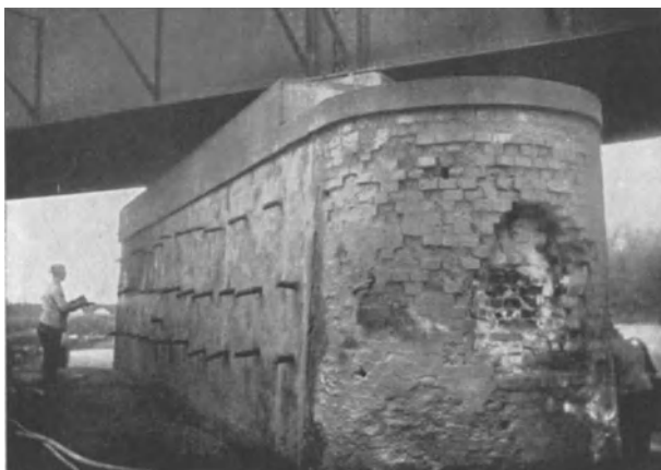
Abb. 143. Fundament der Klodnitzbrücke, das später durch Einpressen von Zement verfestigt wurde: Anbringung der Bohrlöcher.
