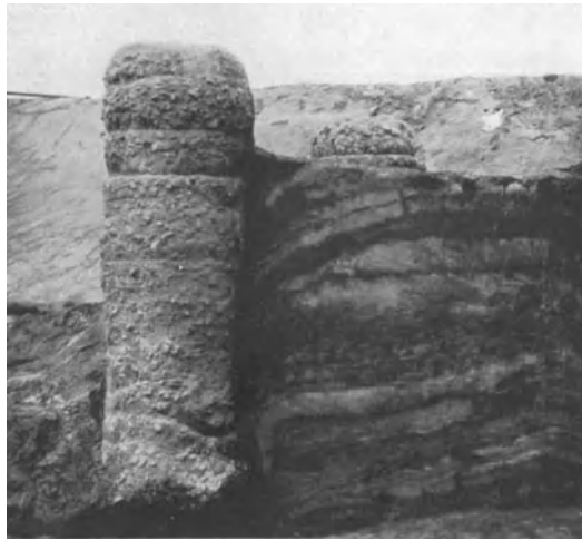
Abb. 106. Frankpfehl, hergestellt durch Rammen mit einem sehr schweren Stampfer beim Austritt aus dem Absenkrohr. Bemerkenswert ist die starke Verdichtung des Betons und die damit verbundene Herunterdrückung des Erdrucks (vgl. die verschiedenen abgeboigten Schichten bei der Rammung ausgegrabener Pfähle).
