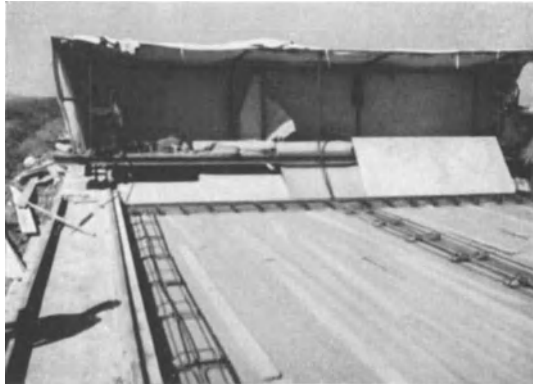
Abb. 108. Vorstrecken von Papierunterlagen bei Betonstraßenbau vor Aufbringung des Betons: Die Randbewehrung ist bereits vorgestreckt.
