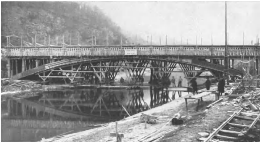
Abb. 166. Brücke in der Schalung (s. auch Abb. 167).
