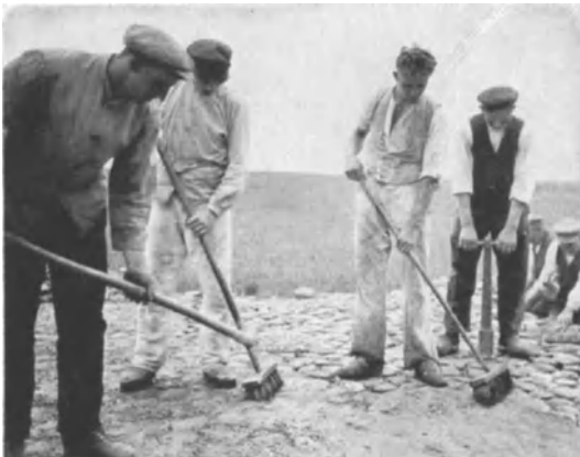
Abb. 123. Einbürsten des Mörtels bei dem Streit'schen Verfahren. Abb. 123.)
