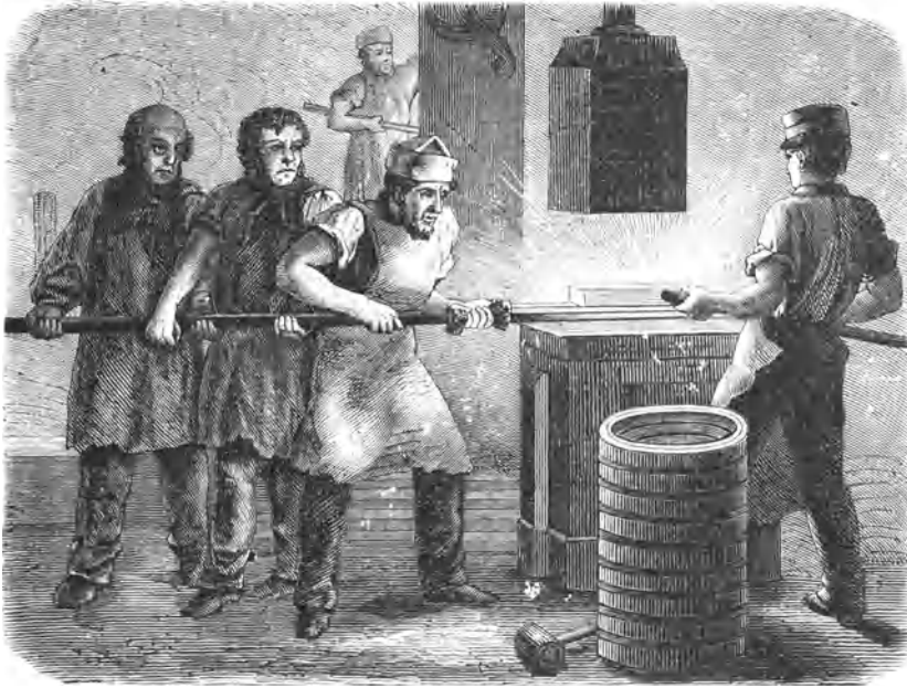
Fig. 249. Herstellung der Eisenstäbe für das Armstrong - Geschützrohr.
