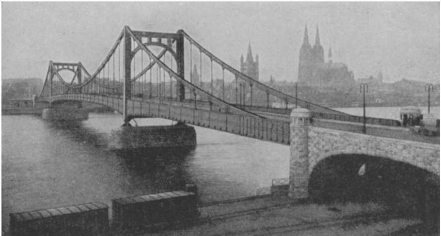
Abb. 162. Hängebrücke über den Rhein bei Köln (erbaut von der Maschinenfabrik Augsburg-Nürnberg). (TWL 1447.)
