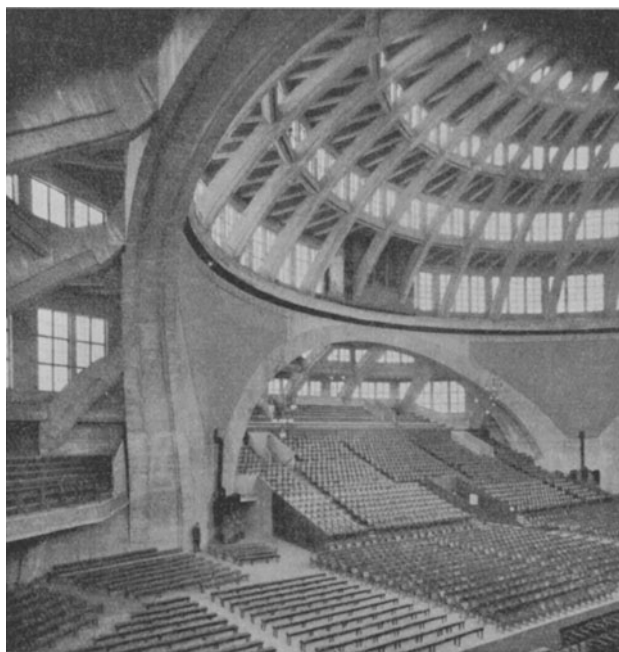
Abb.165. Teilansicht des Innern der Jahrhunderthalle in Breslau (gebaut in Eisenbeton von Dyckerhoff & Widmann, Dresden). (TWL 16 049.)
