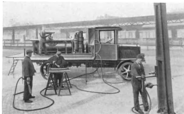
Abb. 148 Älterer fahrbarer Druckluffterzeuger mit stehendem Kompressor Bauart SS
