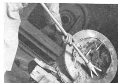
Abb. 75 Gußputzen mit FMA-Abbauhammer Tabelle 24 Nr. 21—35
