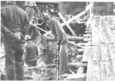
Abb. 86 Fundamentaushub m. FMA-Aufbruchhammer Tabelle 24 Nr. 1—3, 21—35
