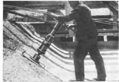
Abb. 81 Böschungstampfen mit FMA-Stampfer Tabelle 24 Nr. 4, 1—3
