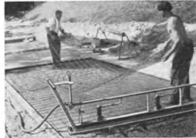
Abb. 79 Betonstampfen mit FMA-Vibrator Tabelle 24 Nr. 51—53
