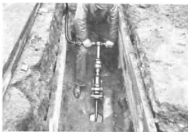
Abb. 88 Grabenaushub mit FMA-Spatenhammer Tabelle 24 Nr. 21/22
