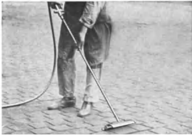
Abb. 108 Fugen ausblasen
