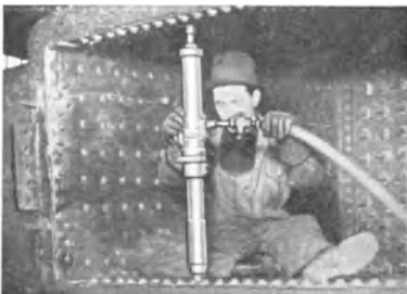
Abb. 46 Kesselnieten mit FMA-Spanten-Niethammer Tabelle 22 Nr. 41—45/51—55
