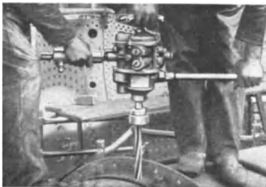
Abb. 64 Aufreiben mit FMA-Bohrmaschine Tabelle 26 Nr. 1—15/31—35
