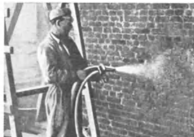
Abb. 107 Torkretverfahren Auftragen von Zement auf Mauerwerk
