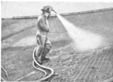
Abb. 106 Torkretverfahren Auftragen von Zement auf Flächen
