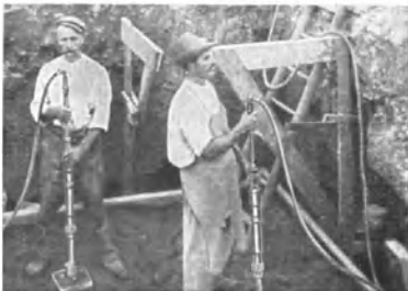
Abb. 82 Betonstampfen mit FMA-Stampfer Tabelle 24 Nr. 41—48
