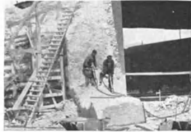
Abb. 85 Brückenabbruch mit FMA-Aufbruchhammer Tabelle 24 Nr. 1—3, 31—35
