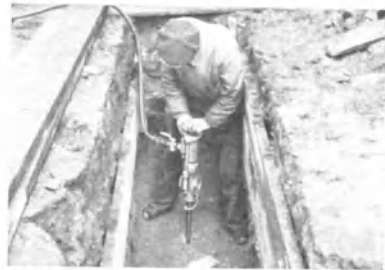
Abb. 87 Gesteinbohren mit FMA-Bohrhammer
