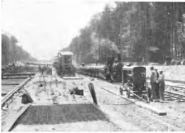
Abb. 78 Straßenbau mit fahrbarem FMA-Kompressor Seite 176
