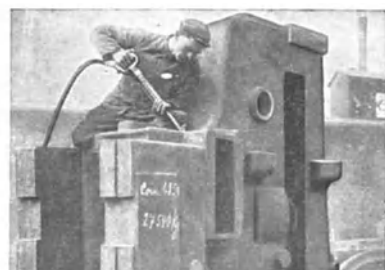
Abb. 77 Gußputzen mit FMA-Meißelhammer Tabelle 23 Nr. 1—24
