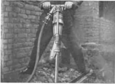
Abb. 84 Fundamentbrechen m. FMA-Aufbruchhammer Tabelle 24 Nr. 1—3, 31—35
