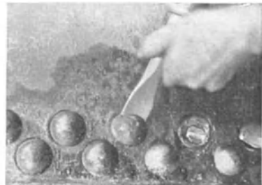
Abb. 53 Abscheren mit FMA-Stemhammer Tabelle 23 Nr. 1—24
