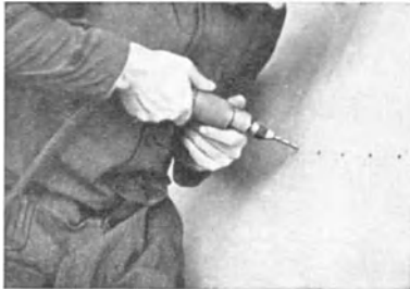
Abb. 68 Bohren mit FMA-Bohrmaschine Tabelle 25 Nr. 61—65
