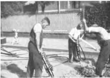
Abb. 80 Betonaufbrechen mit FMA-Aufbruchhammer Tabelle 24 Nr. 1—3
