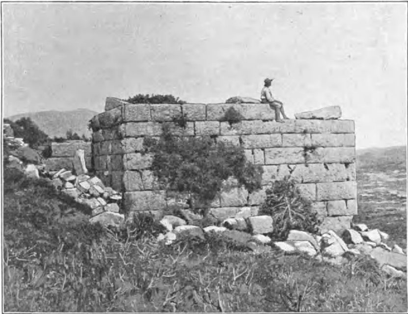
295. Hellenistischer Turm auf Samos (Nordseite).
