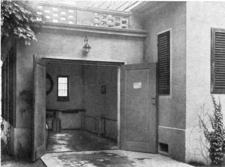
Abb. 11. Angebaute Einzelgarage mit angeschlossenem Heizkörper.
