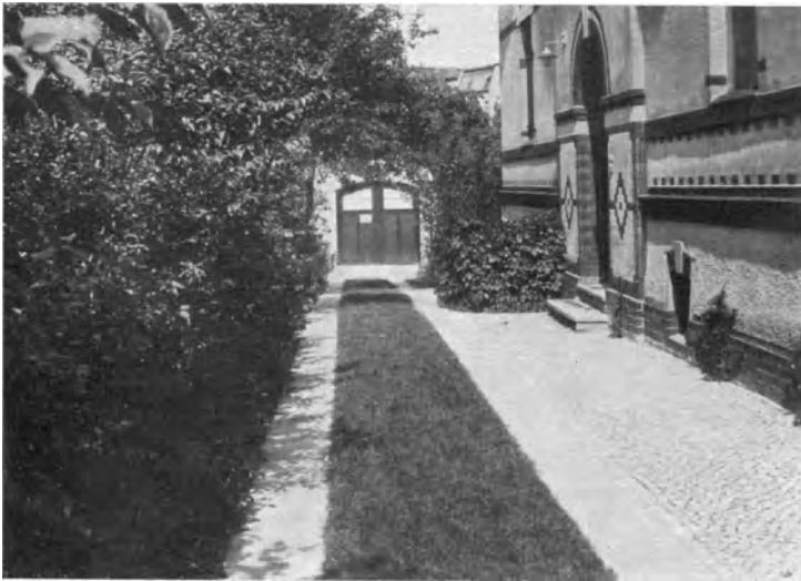
Abb. 10. Teilweise Abpflasterung des Zufahrtweges.
