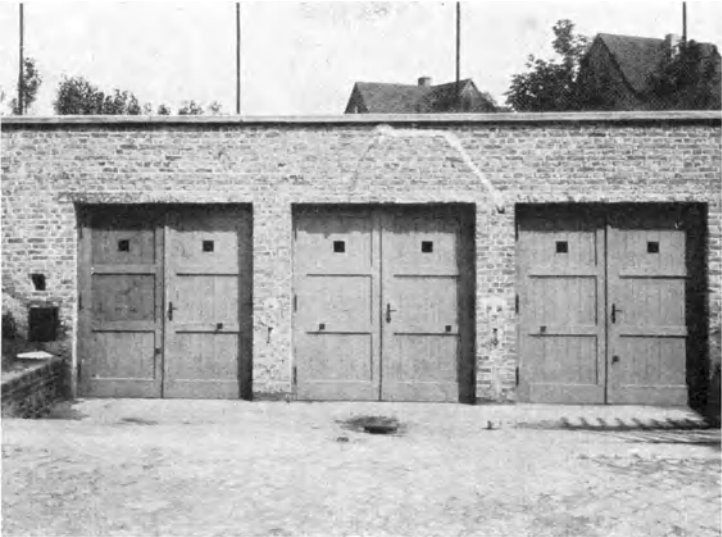
Abb. 17. Drei Garagen unter einem Tennisplatz (Baufaufnahme).
