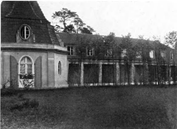
Abb. 18. Garage für acht Wagen als Nebengebäude.
