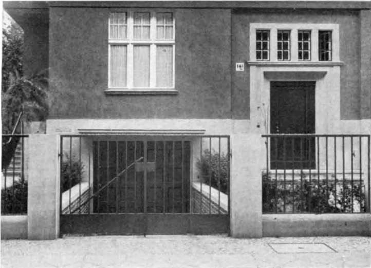
Abb. 23. Einzelboxe mit durch den Vorgarten durchlaufender abfallender Rampe.
