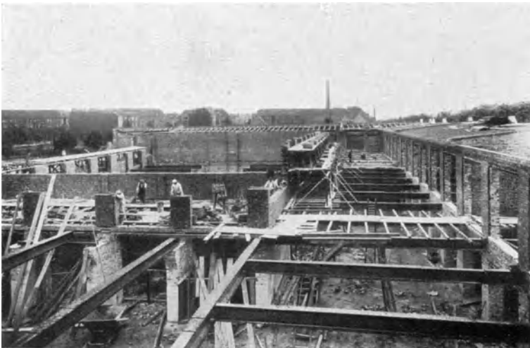
Abb. 40. Garage der Stoglitzer Garagenbau-Gesellschaft, Bauzustand 10. 7. 1925.
