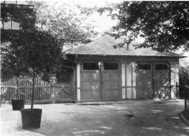
Abb. 14. Freistehende Doppelgarage ohne Chauffeurwohnung.
