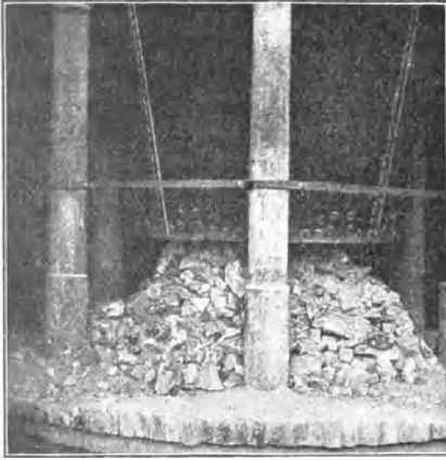
Abb. 210. Ablagerung des Kalkes an der Abzugsöffnung nach dem Böschungswinkel.
