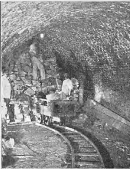
Abb. 8. Setzen der Kalksteine im Ringofen.
