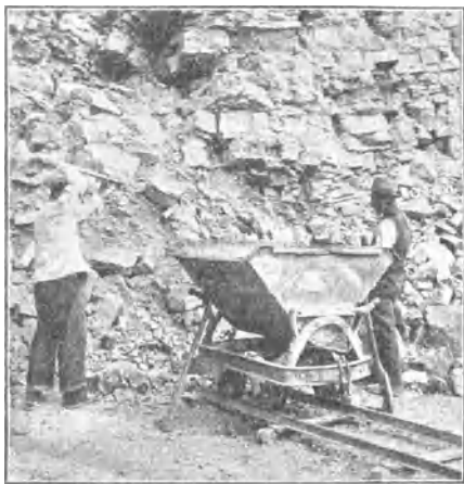
Abb. 174. Ungleichmäßigkeit der Kalksteine im Bruch.
