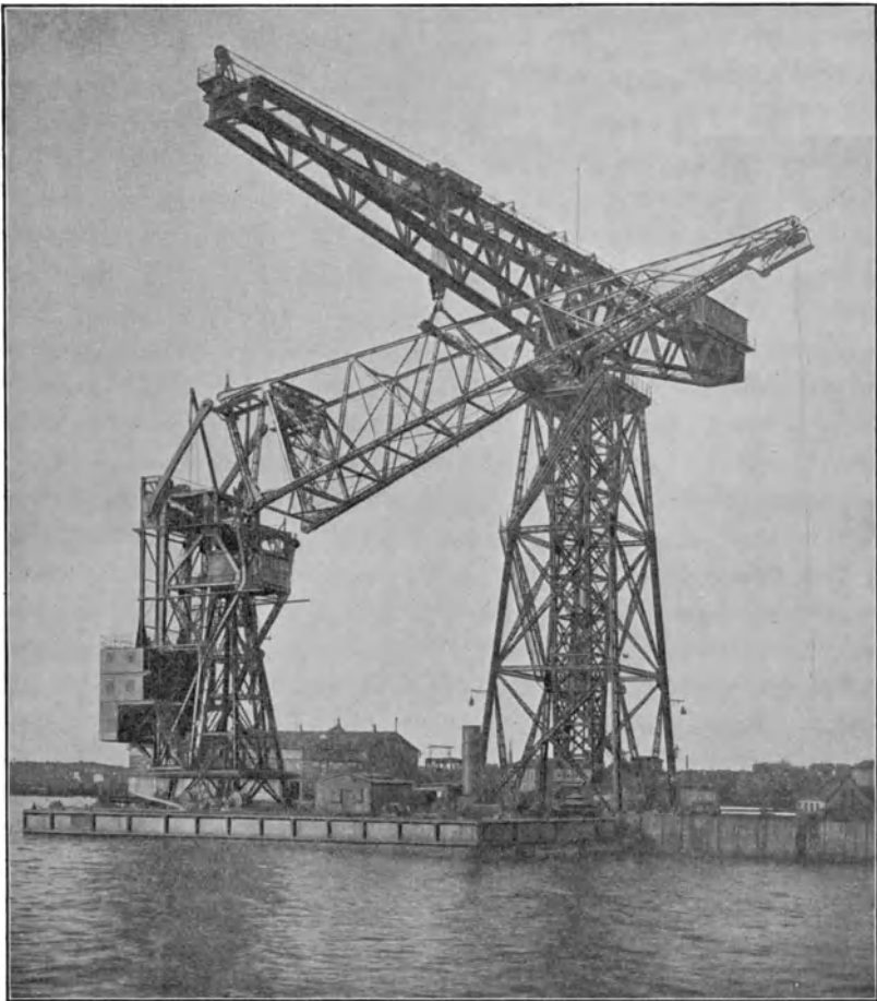
150 Tonnen-Schwimmkran der Kaiserl. Werft, Kiel.
