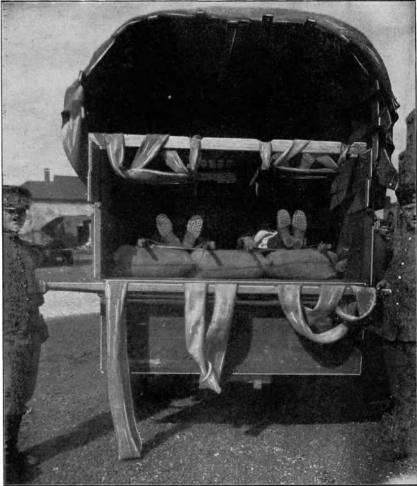
Bild 62. Lagerung in alten Gummischläuchen. Unten: Darstellung der Art der Schlaufenbildung.
