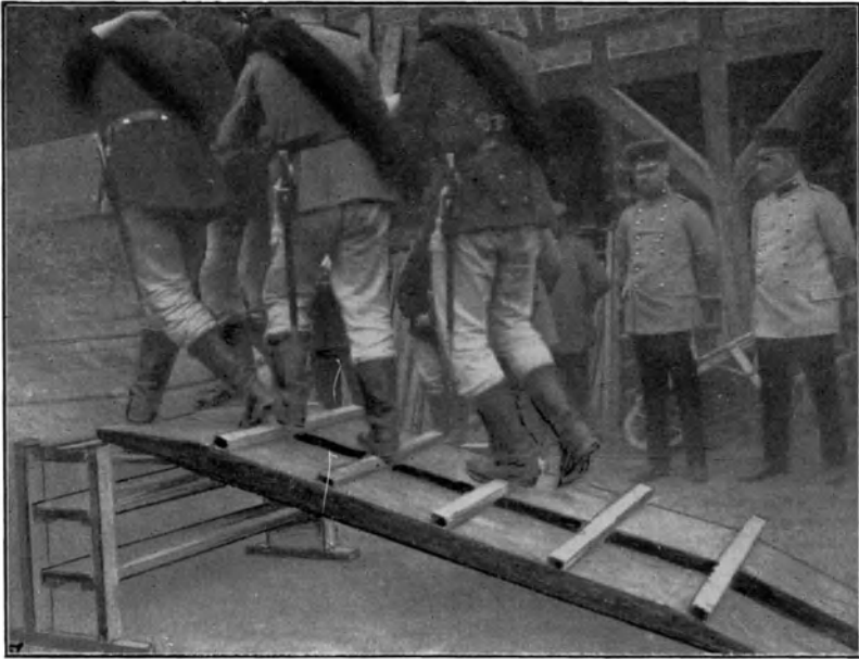
Bild 65. Rampe für den Anhänger an der Seite zum Einladen von Verwundeten ohne Krankentrage.
