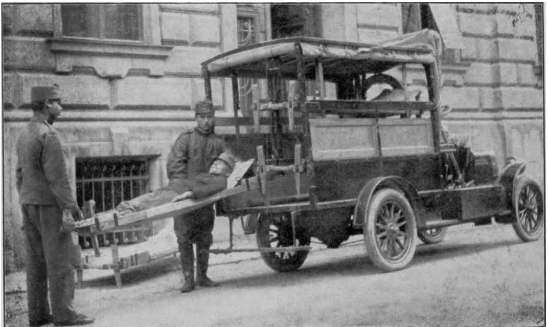
Bild 25. Österreichischer Krankenkraftwagen für Verpflegungsnachschub mit Lagerungsvorrichtung für Kranke.
