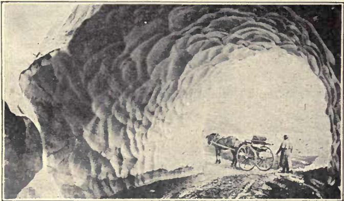
Snetunnel ved Haukelid.
