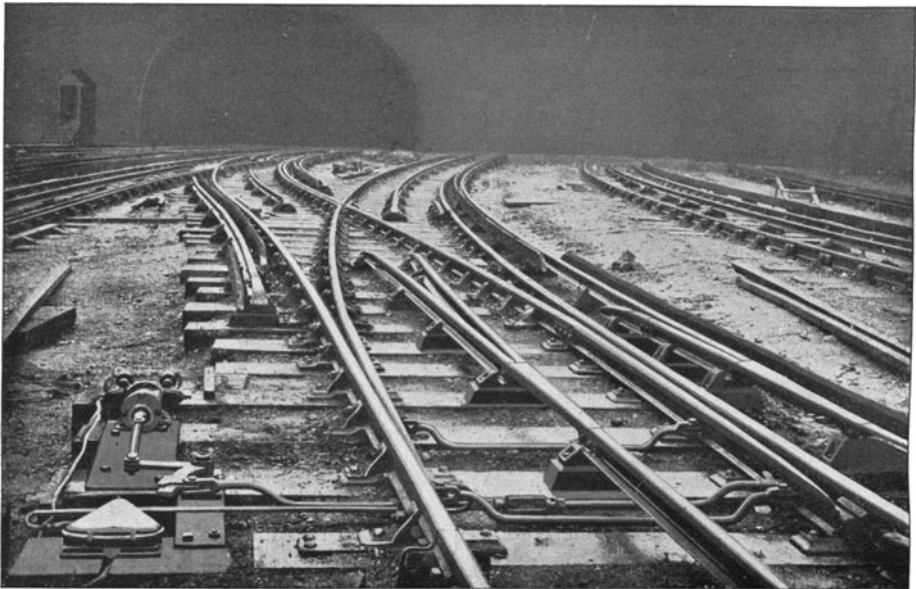
Abb. 25. Stumpfweiche mit Druckluftantrieb (Distriktbahn).
