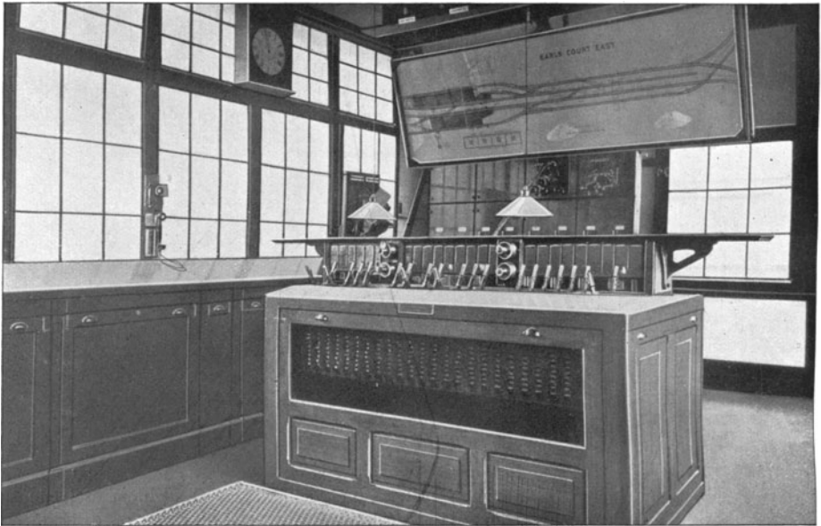
Abb. 39. Ost-Stellwerk Earls Court. (Distriktbahn.)
