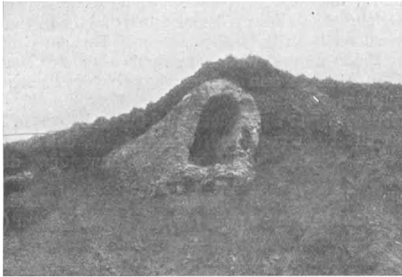
Abb. 1. Römische Wasserleitung aus der Eifel nach Köln, 1,50 m hoch 100 km lang, erbaut um das Jahr 100 nach Christi Geburt, aus Romanzementbeton.
