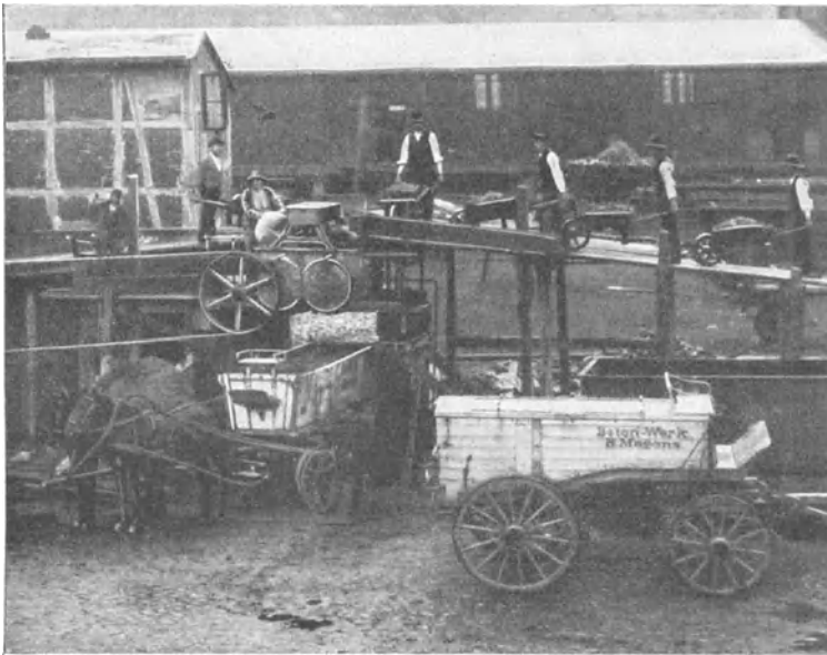
Abb. 8. Herstellung von Transportbeton (Betonwerk Magens & Co., Hamburg.)
