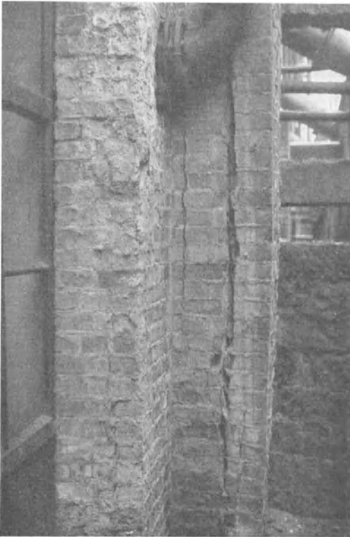
Abb. 54. Wiederherstellung eines zerstörten Mauerwerkpfilers. (Aufn. Ob.-Ing. Goebel, Ludwigshafen.)
