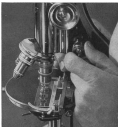
Abb. 6l. Untersuchung der Präparate mit der Ölimmersion (unter Zuhilfenahme eines Kreuztisches)
