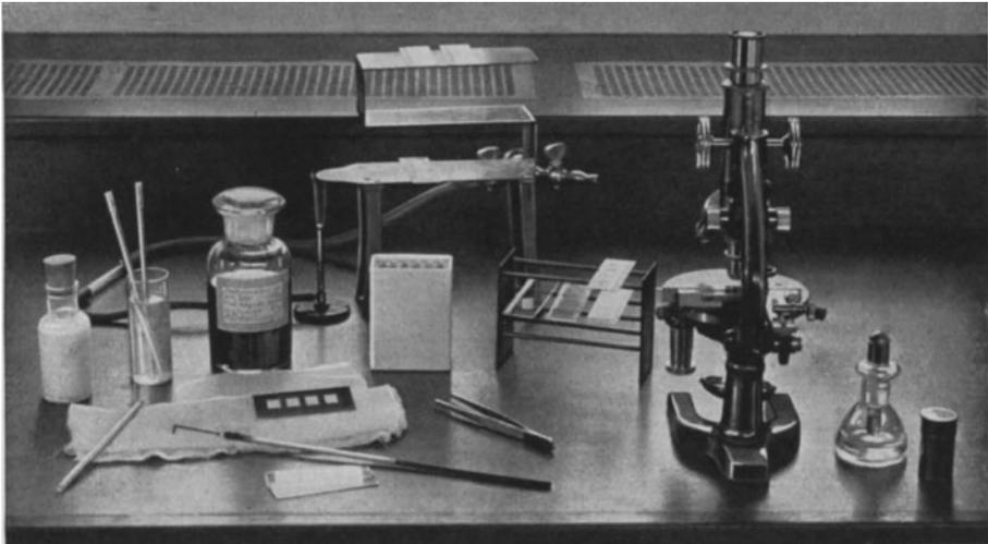
Abb. 4. Apparatur zur direkten Keimzählmethode nach BREED
