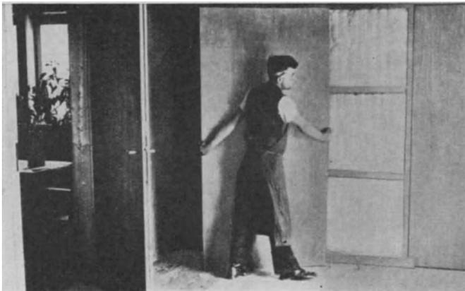
Abb. 78 b. Isolierung einer Hauswand mit Glaswatte-Matten.
