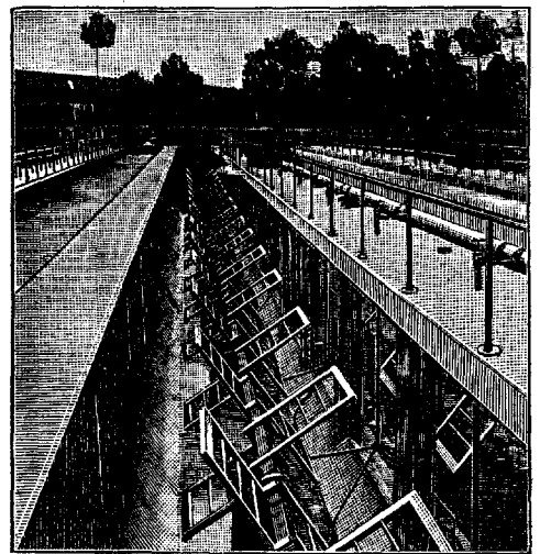
Рис. 5. Аэротэнк с продольной мешалкой (Эссен-Реллингаузен).
