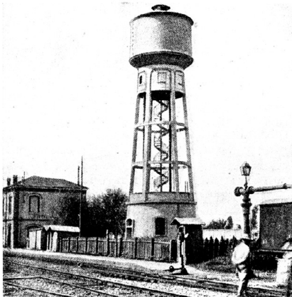
Фиг. 61. Водонапорная башня.
