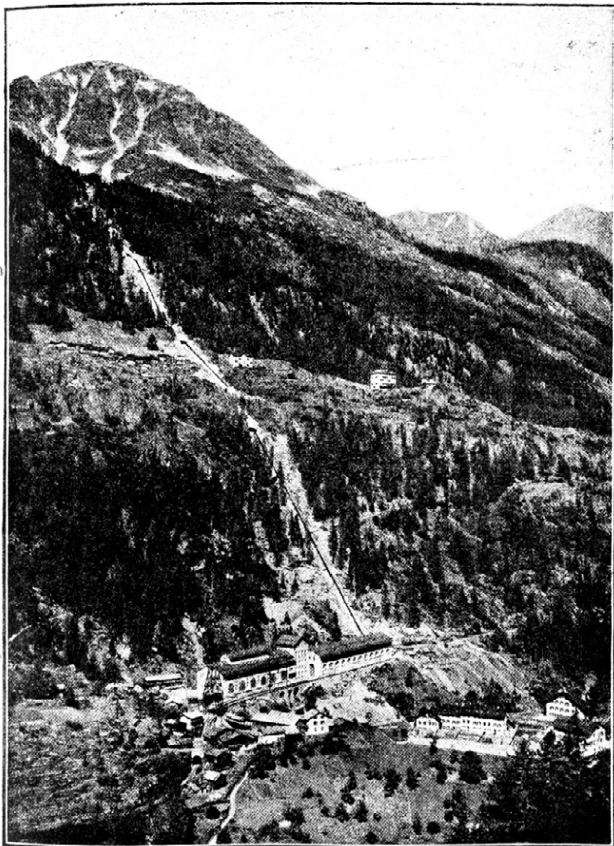
Фиг. 204. Электрическая станция швейцарских дорог „Барберина“.
