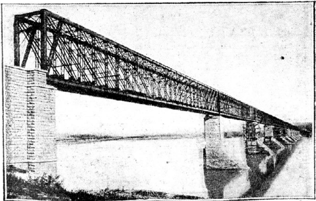
Фиг. 180. Железнодорожный мост через р. Волгу. Построен в 1879 г.
