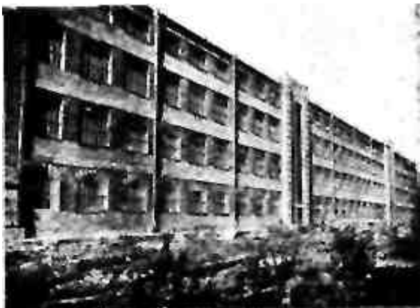
Інж. Куклін. Новий будинок трикотажної фабрики (збудовано 1930 р.).
