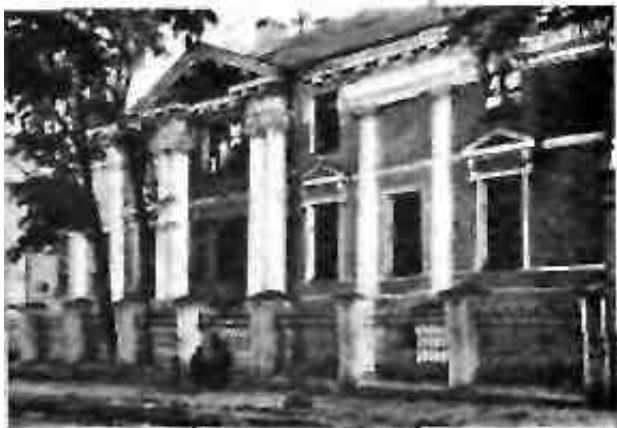
Будинок по Покровській вул. № 5.
