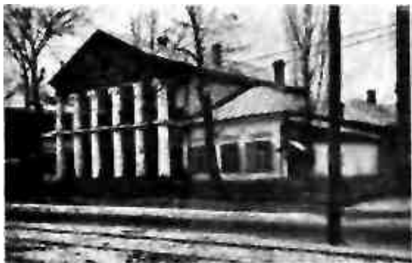
Будинок по вул. Червонопрапорного заводу (Московській) № 40
