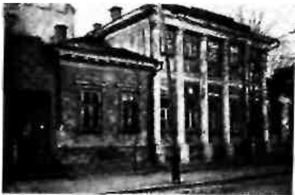
Будинок на вул. Енгельса № 34.
