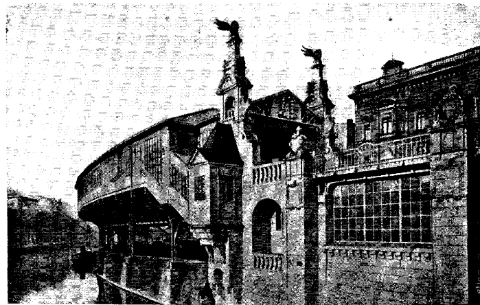
Эстакада М. со станцией на Ландверском канале в Берлине.
