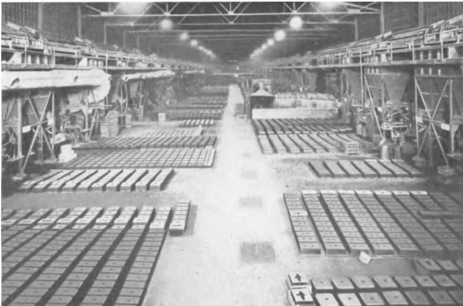
Abb. 23. Gießerei mit mechanischem Sandtransport.
