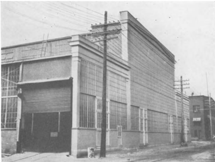
Abb. 2. Moderner Fabrikbau in ebenerdiger Ausführung.
