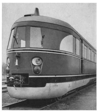
Abb. 1. Kopf des zweiteiligen Schnelltriebwagens der deutschen Reichsbahn (Fliegender Hamburger),
