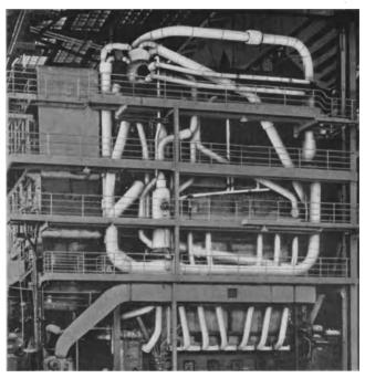
Abb. 11. Ansicht eines neuzeitlichen großen Sektionalkessels mit allseitig gekühltem Feuerraum.
