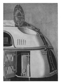
167. Einbau eines Holzgasgenerators, Bauart Imbert, Köln, in einem windschnittigen Omnibusaufbau.
