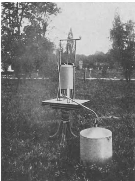
Abb. 9. Der Glockenapparat von LUNDEGÄRDH mit der Bodenglocke zur Messung der Bodenatmung. (Biochem. Z. 193, 352, Fig. 1.)
