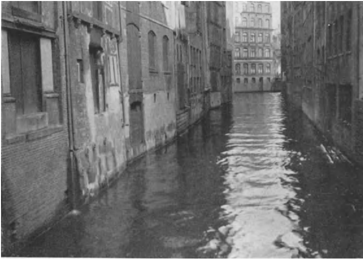
Abb. 4. Dieselbe Stelle wie in Abb. 3 rund 6 Stunden später; Wassertiefe etwa 2 m. Man beachte die Lage der Knüppel rechts, die den Anprall der Kähne gegen die Mauer verhindern sollen, auf beiden Bildern. Auch am Mauerwerke links ist das Steigen zu erkennen. Aufn. H. Thorade.
