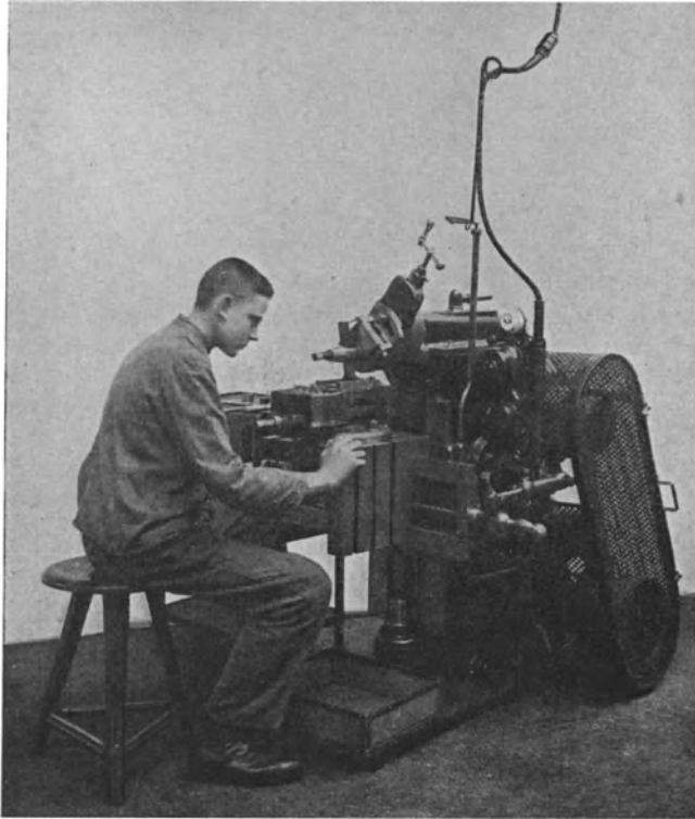
Abb. 52. Stoß- (Shaping-) Maschine für die Lehrlingswerkstätte der Allgemeinen Elektrizitäts-Gesellschaft Berlin, Abteilung Apparatefabrik.
