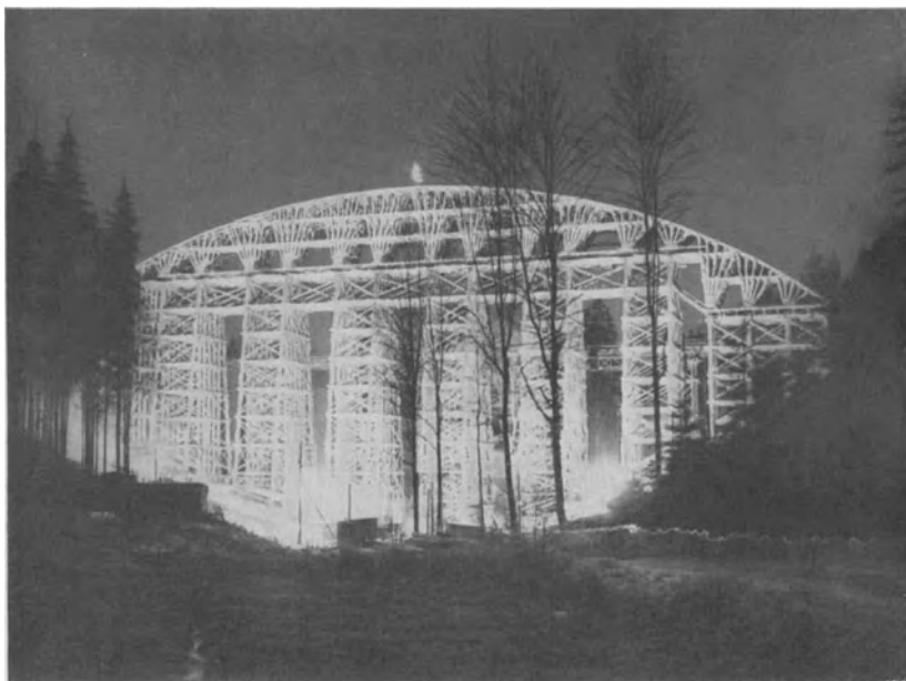
Abb. 130b. Nachtaufnahme des Lehrgerüsts.
