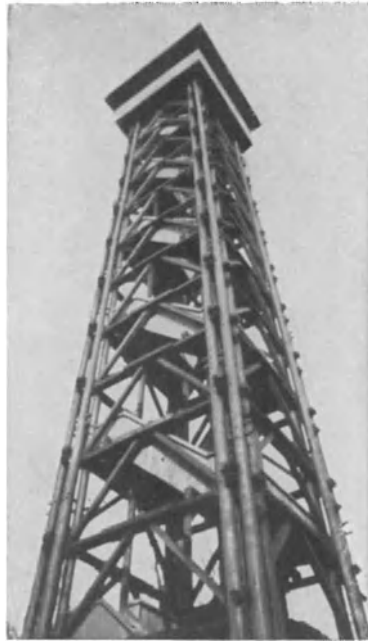
Abb. 114b. Der fertige Turm.
