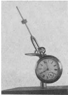
Abb. 356. Resonanz zwischen Uhrgehäuse und Unruhe.
