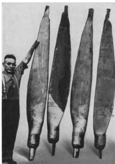
Abb. 213. Schmiederohlinge für Elektron-Luftschrauben. Hersteller: I. G. Farbenindustrie, Bitterfeld.
