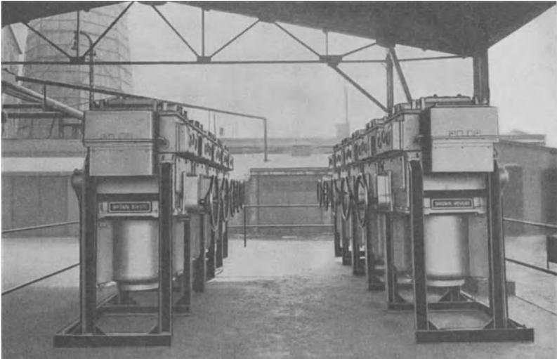
Abb. 53. Gekapselte Schaltanlage mit 6 kV Ringleitungsfeldern im Freien, aufgestellt in einer chemischen Fabrik.
