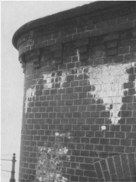
Abb. 52. Kalkausblühungen. Aus dem sehr stark kalkhaltigen Mörtel hat sich Kalk als doppelkohlensaurer Kalk gelöst und als harte weiße Schicht wieder abgetrennt.
