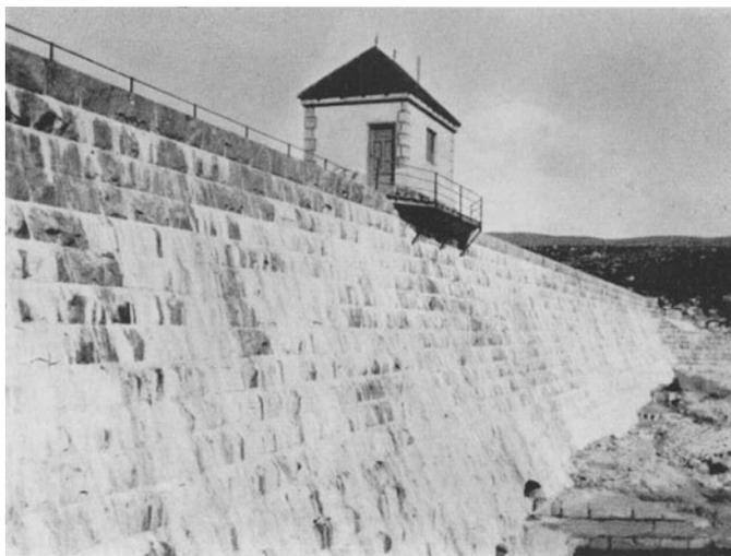
Abb. 30. In Zerstörung begriffene norwegische Talsperre: Das sehr weiche kohlen-säurereiche Wasser zermürbt den Beton. Die starken Kalkausscheidungen weisen auf diese noch nicht in Erscheinung getretene Zermürbung hin.
