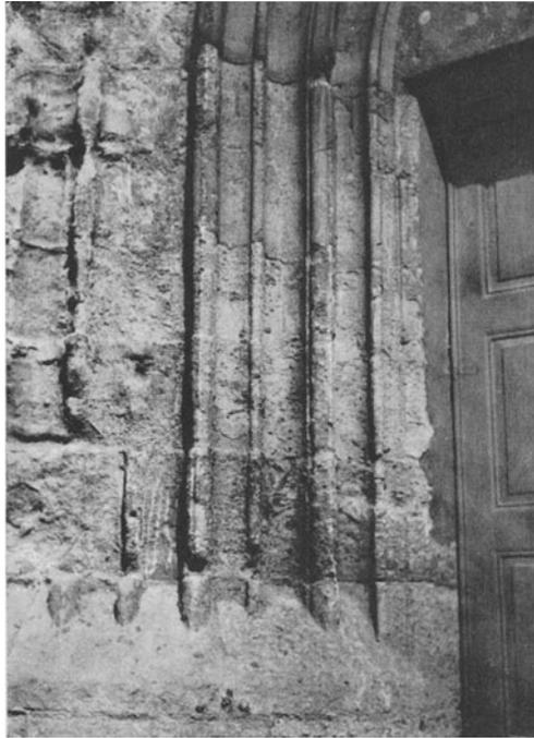
Abb. 14. Verwitterung durch Lösungserscheinungen. Das Bindemittel des Sandstein ist gelöst, der Sand des Sandsteins rieselt herab. Die Lösung tritt nur da ein, wo der Regen einwirken kann, an den geschützten Stellen keine Verwitterung.
