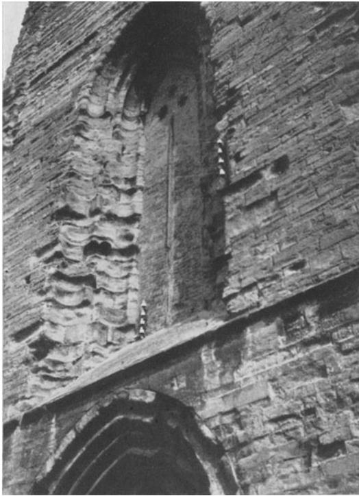
Abb. 9. Verwitterungserscheinungen an einer Soester Kirche: Sandstein ist verhältnismäßig porös und die einzelnen Quarzkörner durch ein wenig widerstandsfähiges Bindemittel verbunden. Das Bindemittel wird durch das Wasser gelöst, der Sand rieselt herab.
