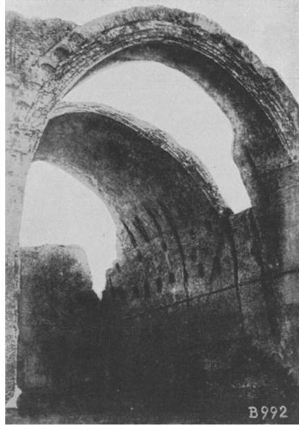
Abb. 4. Palast von Ktesiphon. 3. Stadium der Baustoffverwendung: Verwendung chemisch verändertem und geformtem Baustoff (Ziegelbau): Lehm ist zu Ziegel gebrannt, also chemisch verändert. Die Ziegel sind vermauert mit gebranntem Kalk, also durch chemische Veränderung entstandenen Mörtel.
