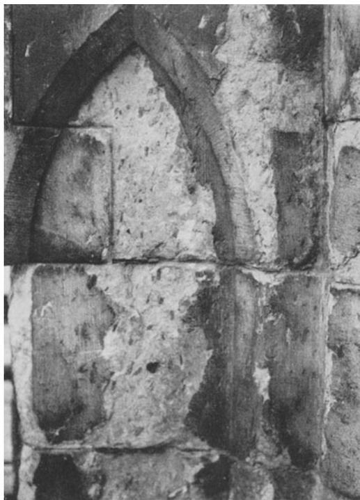
Abb. 10. Verwitterung durch Salzbildung: Das auskristallisierte Salz zersprengt den Stein. Die Auskristallisierung tritt ein, wo starke Verdunstung stattfindet, also auch an geschützten Stellen, weil hier das schädliche Salz nicht ausgewaschen wird. Vom Regen getroffene Stellen blieben ohne Verwitterung, weil hier das Salz stets ausgewaschen wird.
