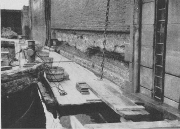
Abb. 43. Zerstörung von Beton hinter Ziegelsteinverblendung: Die Verblendung hält naturgemäß auf längere Zeit nicht dicht. Der Beton war mit Rücksicht auf die Verblendung fälschlicherweise porös gemacht und wurde durch das Sulfat zum Treiben gebracht. Die Raumvergrößerung führte zu Aufbauschung des Mauerwerks, wobei erst nach längerer Zeit die Zerstörung des Betons offenbart wurde. Man arbeitet deshalb heutzutage ohne Verblendung.
