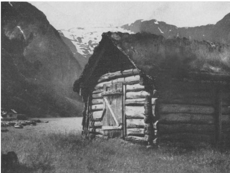
Abb. 3. 2. Stadium der Baustoffverwendung: Verwendung von mechanisch verändertem Baustoff (Blockhaus): Der Fortschritt gegen Stadium I ist deutlich erkennbar, das Holz ist behauen.
