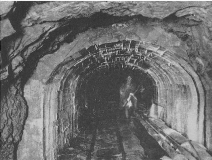
Abb. 12. Stallaktitenbildung in einem Betontunnel: Das Wasser mit einem hohen Gehalt an aggressiver Kohlensäure hat den Kalk des Betons als kohlensauren Kalk gelöst. Aus der Lösung schied sich wieder kohlensaurer Kalk unter Entweichung von Kohlensäure ab.
