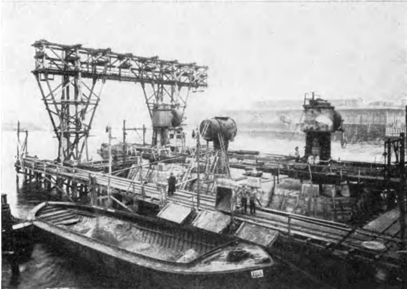
Abb. 173. Baustelle eines Strompfeilers. Zu Abb. 170.
