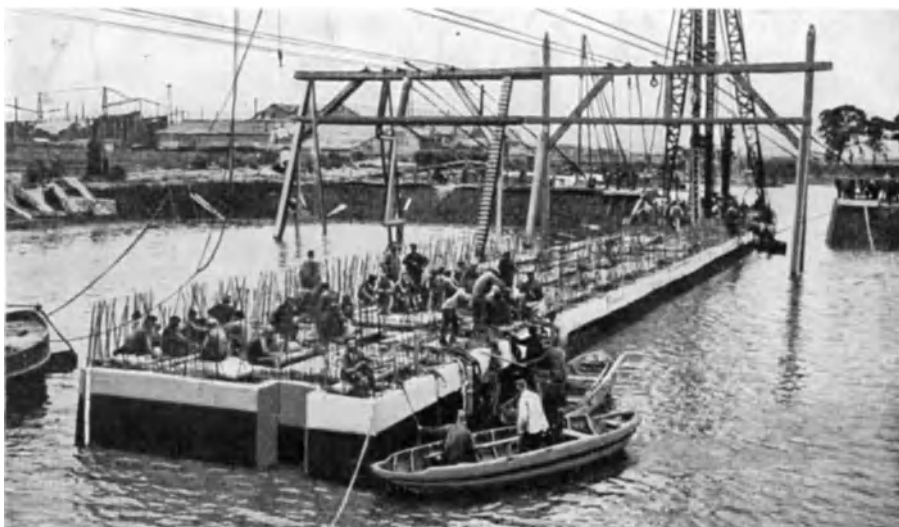
Abb. 147. Ansicht von Abb. 146.
