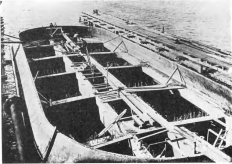
Abb. 171. Aufsicht auf den Schwimmkasten. Zu Abb. 170.
