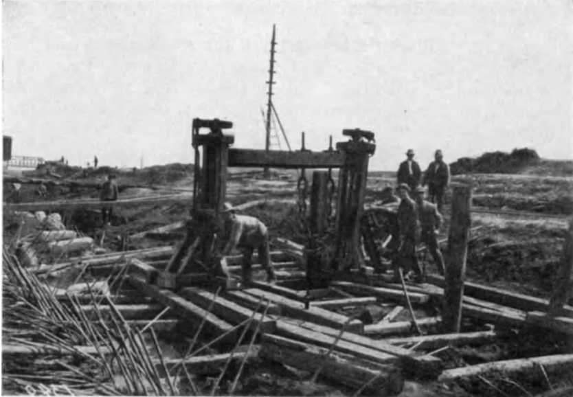
Abb. 174. Spindelhebebock zum Pfahlausziehen.
