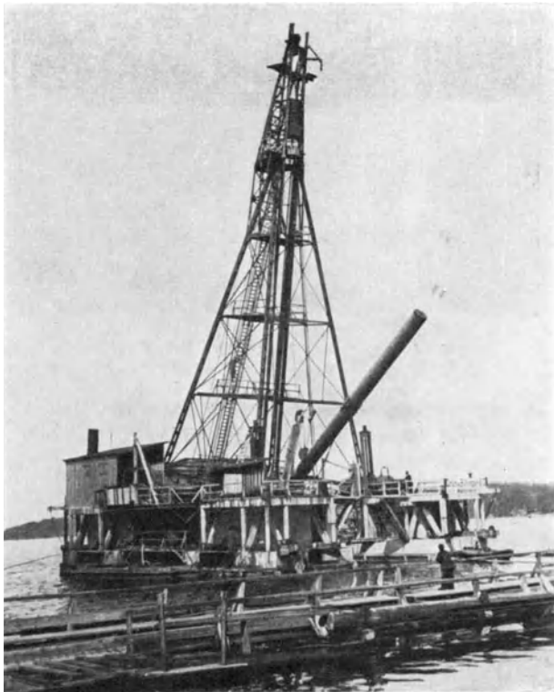
Abb. 84. Ramme für die Lidingöbrücke.
