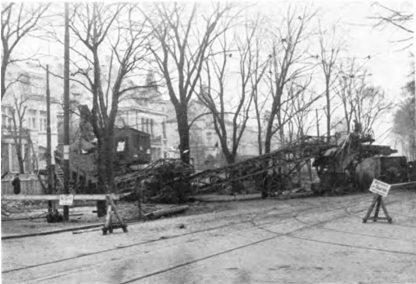
Abb. 67. Bandförderanlage für Bodenaushub.
