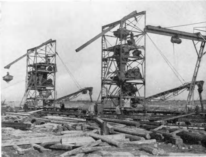
Abb. 154. Fahrbare Betoniereinrichtung für den Kaimauerbau Waltershof.
