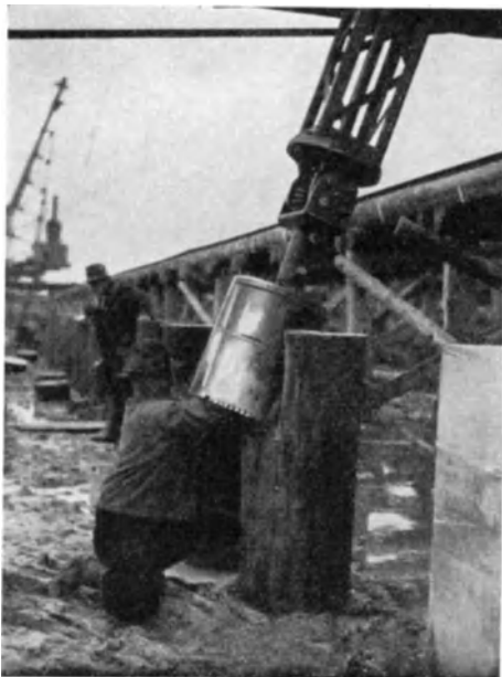
Abb. 181. Universal-Pfahlsäge. Zylinder mit senkrechter Welle.
