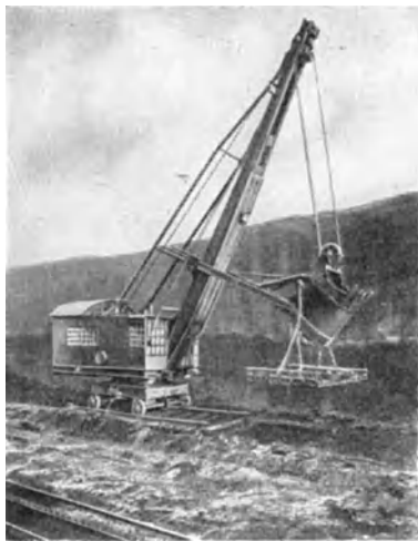
Abb. 111. Bagger, Gleis vorbauend.
