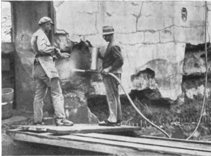
Abb. 21. Wiederherstellung einer Betonmauer im Kraftbauverfahren. (Nach Gebauer, Bauingenieur 1926.)
