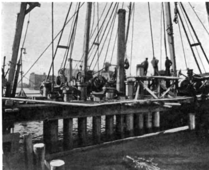
Abb. 78. Ortpfähle beim Bau des Hudsonntunnels in Neuyork.
