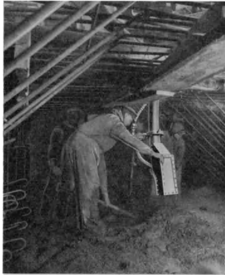
Abb. 153. Pneumatische Betonförderung. System „Torkret“.
