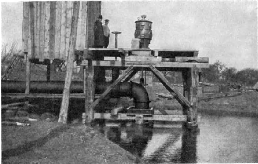
Abb. 94. Schraubenschaufler in Betrieb.
