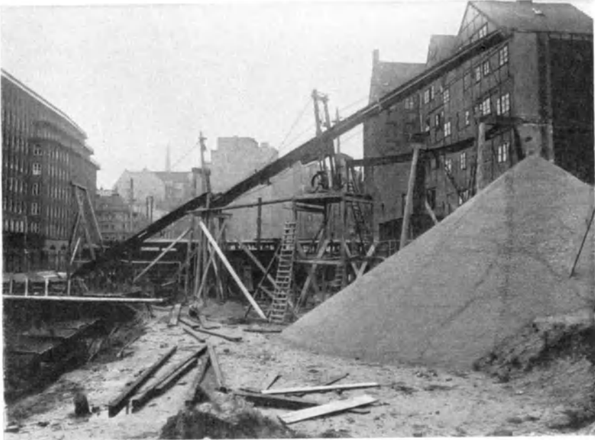
Abb. 66. Bandförderanlage für Baustoffe.
