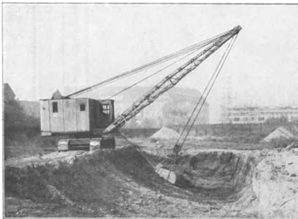
Abb. 105. Eimerseilbagger an der Baugrube.
