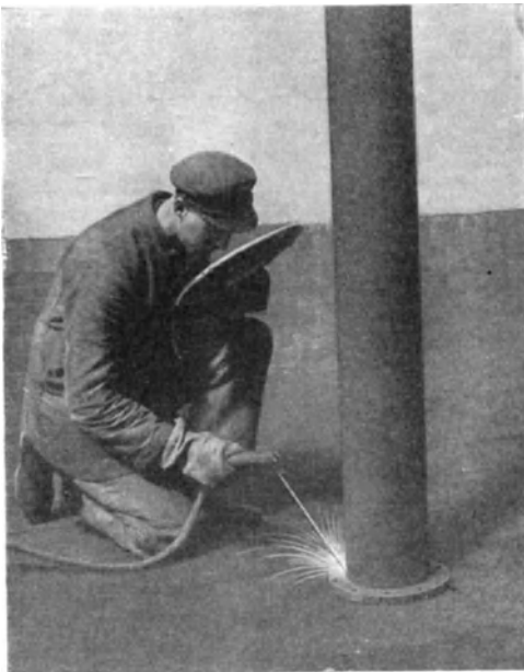
Abb. 118. Lichtbogenschweißung und ihre Zubehörteile. (Siemens-Schuckert-Werke.)
