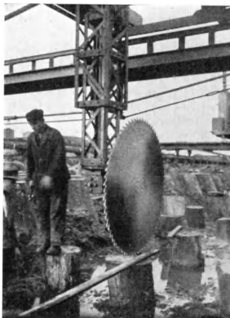
Abb. 182. Universal-Pfahlsäge. Kreissäge mit wagerechter Welle.
