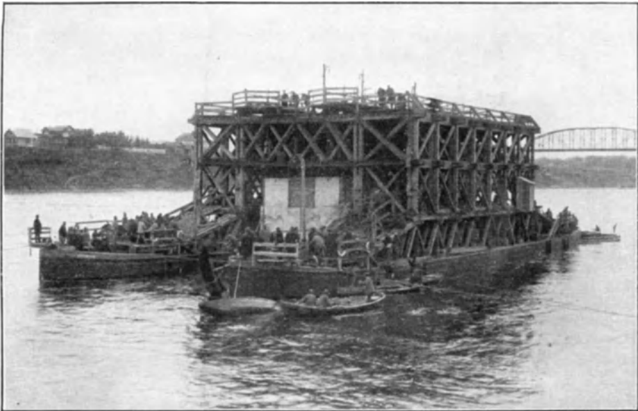
Abb. 177. Transport der Senkkästen für Abb. 176. (Nach Laupmann, Beton und Eisen 1925.)
