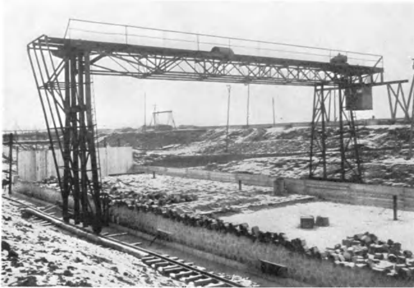
Abb. 48. Fahrbarer Laufkran für Bauzwecke.
