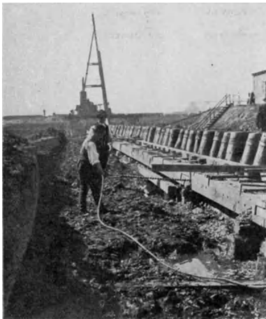
Abb. 124. Preßluftbohrmaschine auf der Baustelle.
