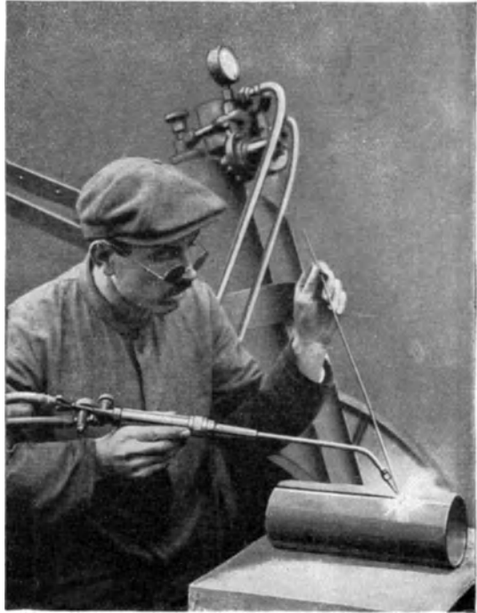
Abb. 115. Gasschmelzschweißung und ihre Zubehörteile. (Griesheim-Elektron.)
