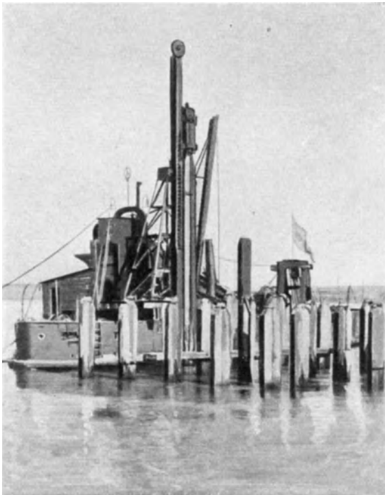
Abb. 168. Pfahlhammer in Tätigkeit.
