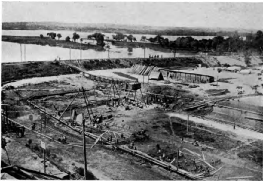
Abb. 209. Grundwassersenkung Budapester Industrie- und Handelshafen.
