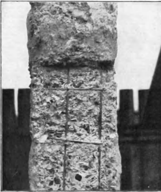
Abb. 67. Straußpfahl mit freigelegter Eisenbewehrung. (Handbuch für Eisenbeton III.)
