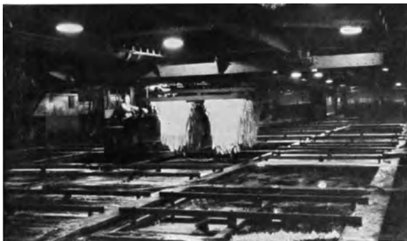
Abb. 286. Gerbgruben für die vegetabilische Gerbung.
